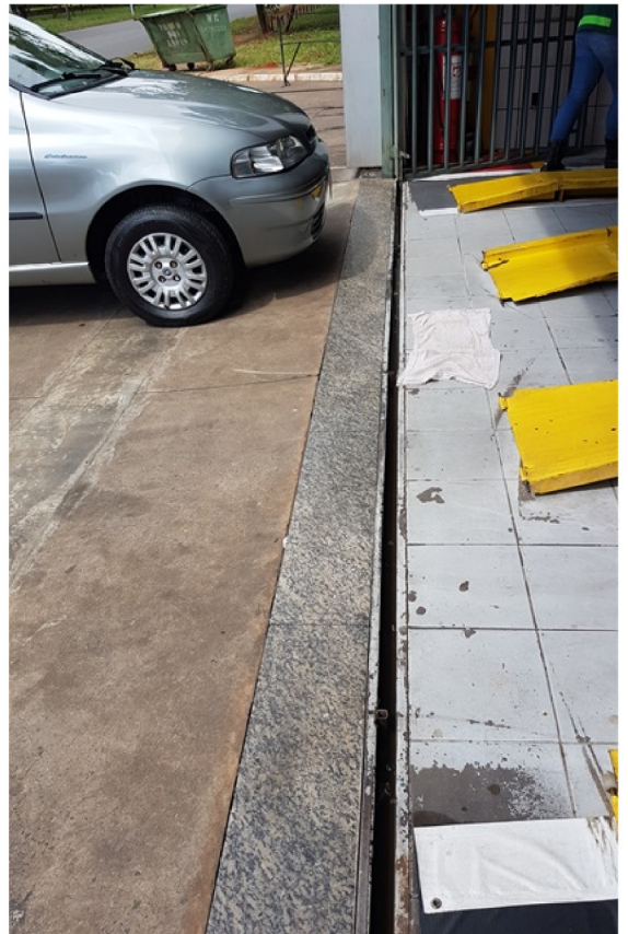
Foto 10. Detalhe dos canaletos da área de lubrificação de veículos
