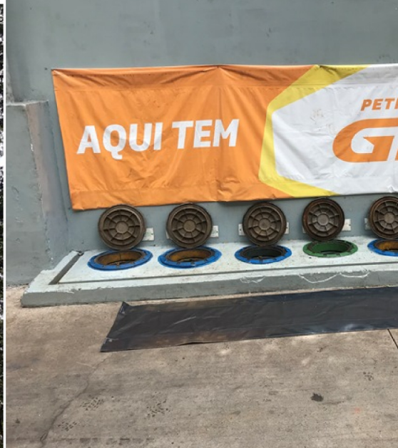
Foto 8. Visão geral das descargas seladas sobre o tanque.
