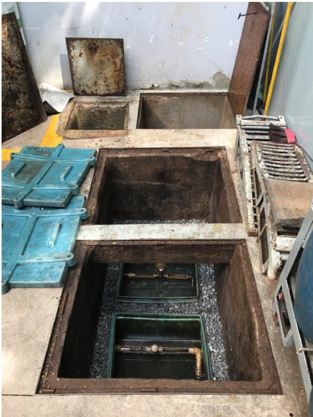
Foto 15. Visão geral do SAO da pista de abastecimento.
