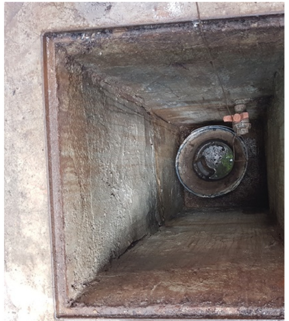
Foto 14. Caixa coletora de óleo do SAO da lavagem.
