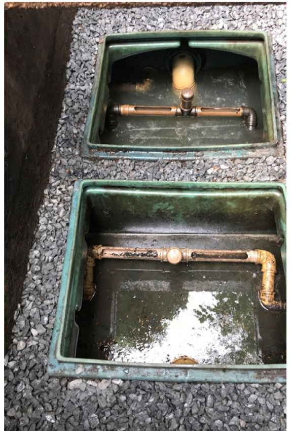
Foto 16. Detalhe da caixa separadora de água e óleo da pista de abastecimento.
