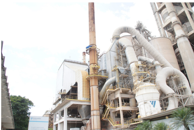
Foto 05 – Vista geral da torre da chaminé e no alto, em azul, o local de coleta do material para análise dos gases e particulados
