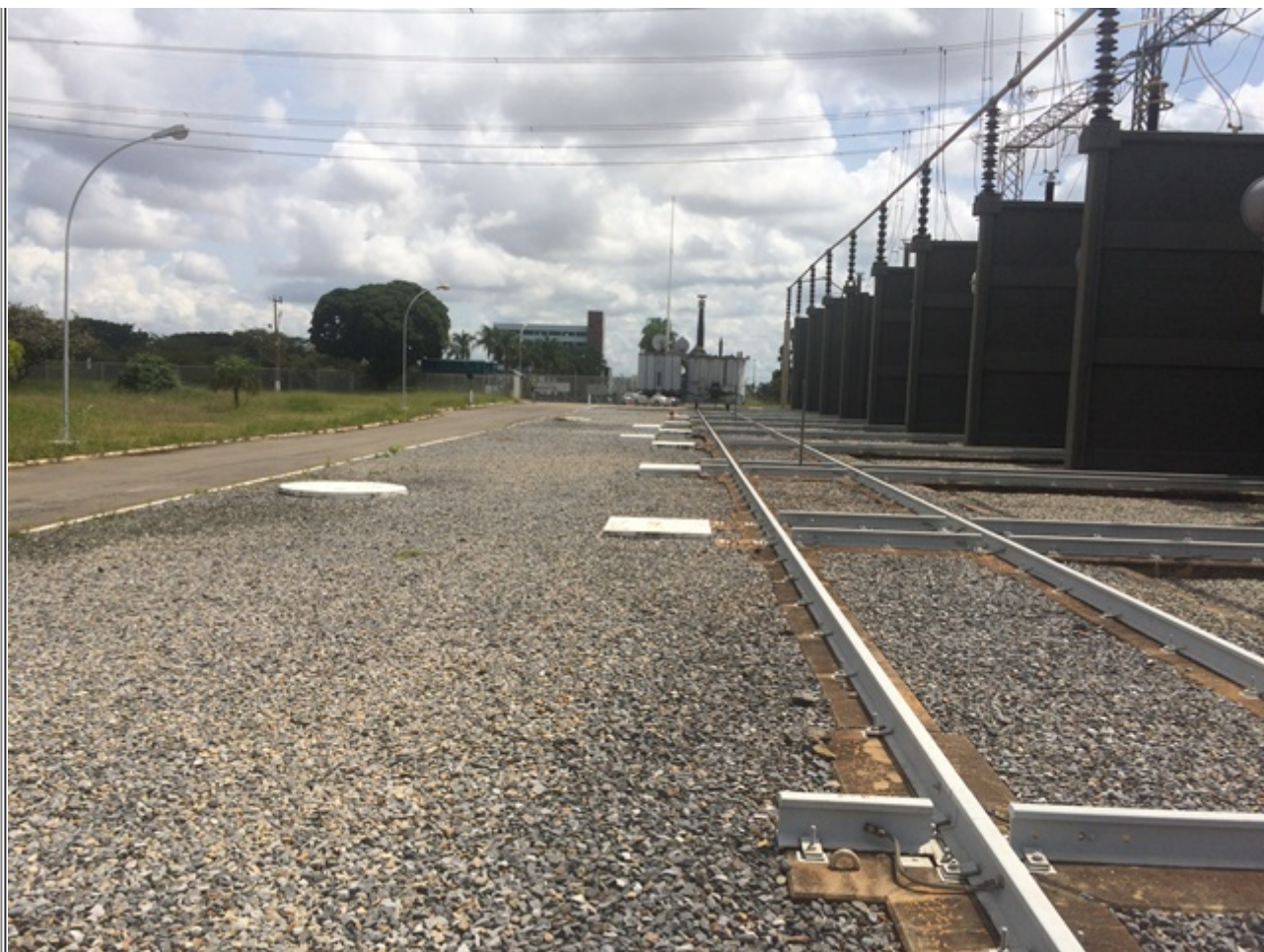
Pátio de Autotransformadores e Bacias de Contenção
