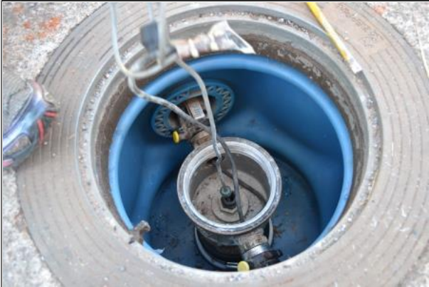
Foto 38 – Detalhe do monitoramento ambiental intersticial de um dos SASC no dia 15/10/2018
