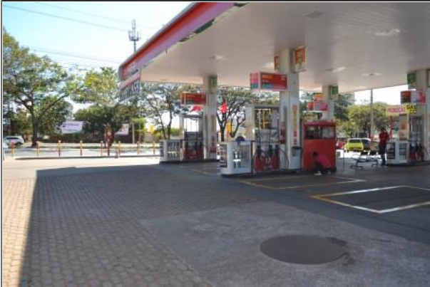
Foto 30 – Visão Geral do SASC.
