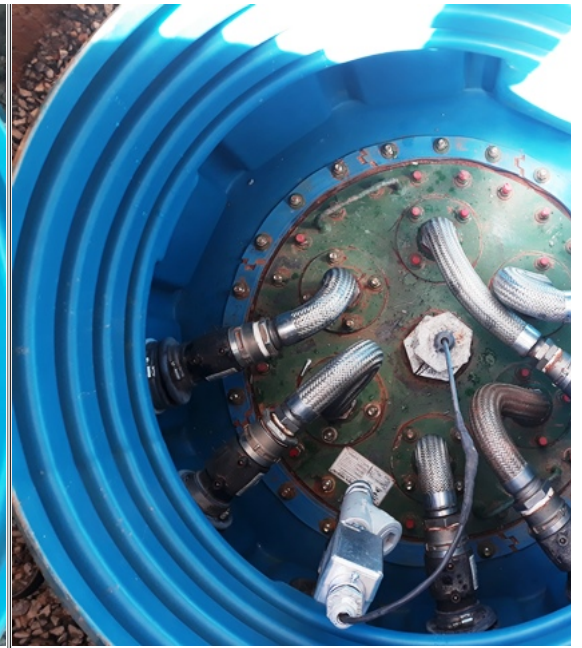
Foto 43 - Aspecto da Câmara de contenção (sump) na boca de vis eletrônico de estoque, tubulação metálica flexível, tubulação subterrânea em PEAD e flanges de vedação.
