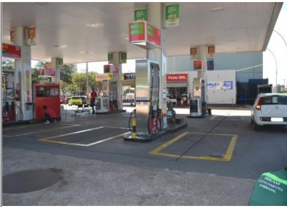
Foto 29 – Visão Geral do SASC.
