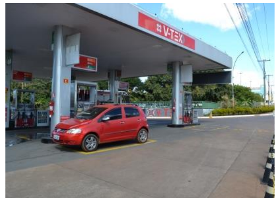
Foto 3 - Visão geral da Pista de Abastecimento
