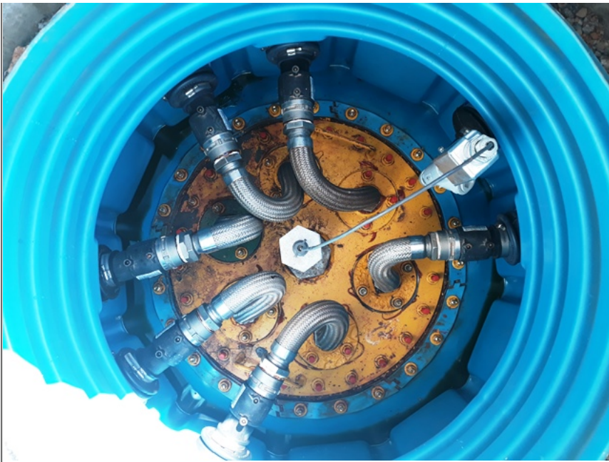
Foto 42 - Aspecto da Câmara de contenção (sump) na boca de visita do tanque com controle eletrônico de estoque, tubulação metálica flexível, tubulação subterrânea em PEAD e flanges de vedação.
