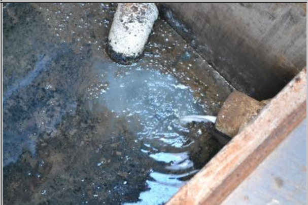
Foto 25 – Teste do funcionamento do SAO da pista de abastecimento
