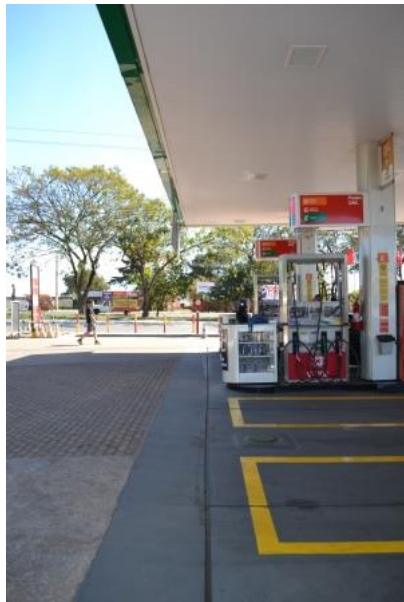
Foto 13 – Canaletes, localizados na pista de abastecimento.
