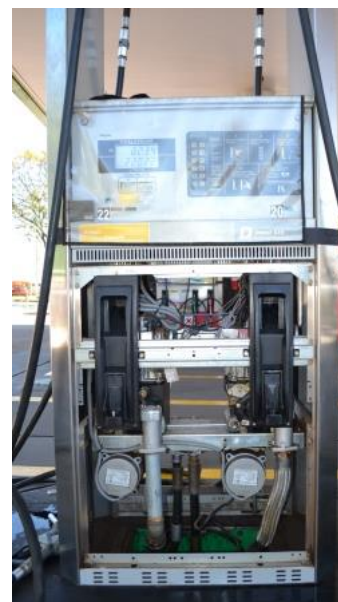
Foto 5 – Unidade de abastecimento com Check-valve .
