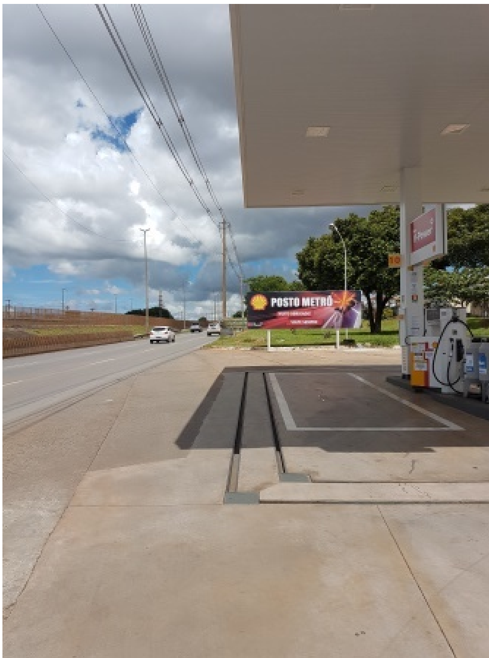
Figura 16: Canaletes localizados na pista de abastecimento 2 (S500 e S10).
