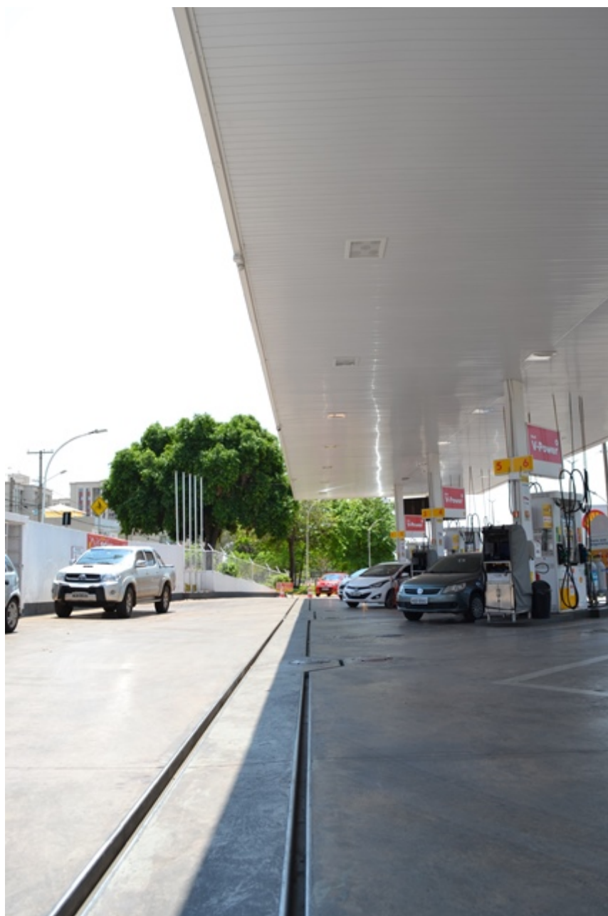
Figura 15: Canaletes localizados na pista de abastecimento 1.
