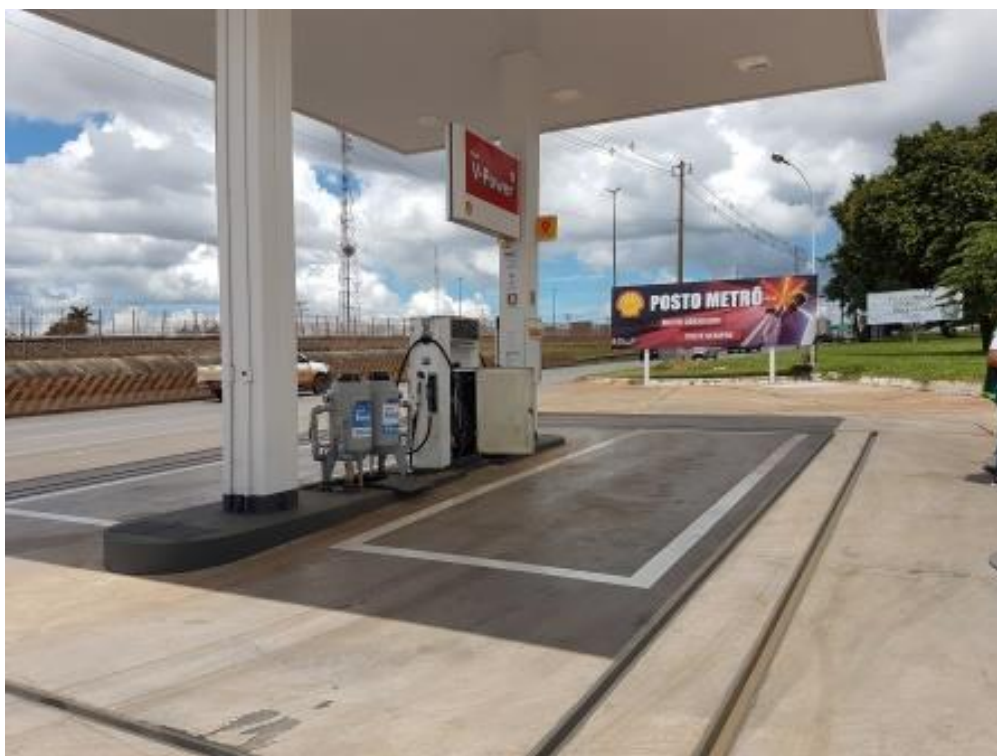
Figura 3: Vista da pista de abastecimento 2 de Diesel (S500 e S10).
