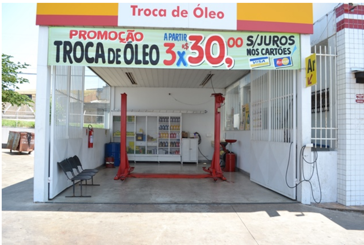
Figura 19 : Área de Lubrificação contida em canaletes.
