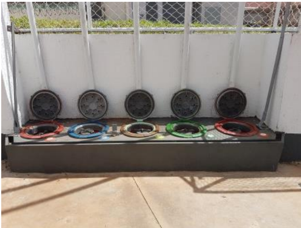
Figura 17: Descarga selada à distância circundada por Canaletes, com respectivos respiros.
