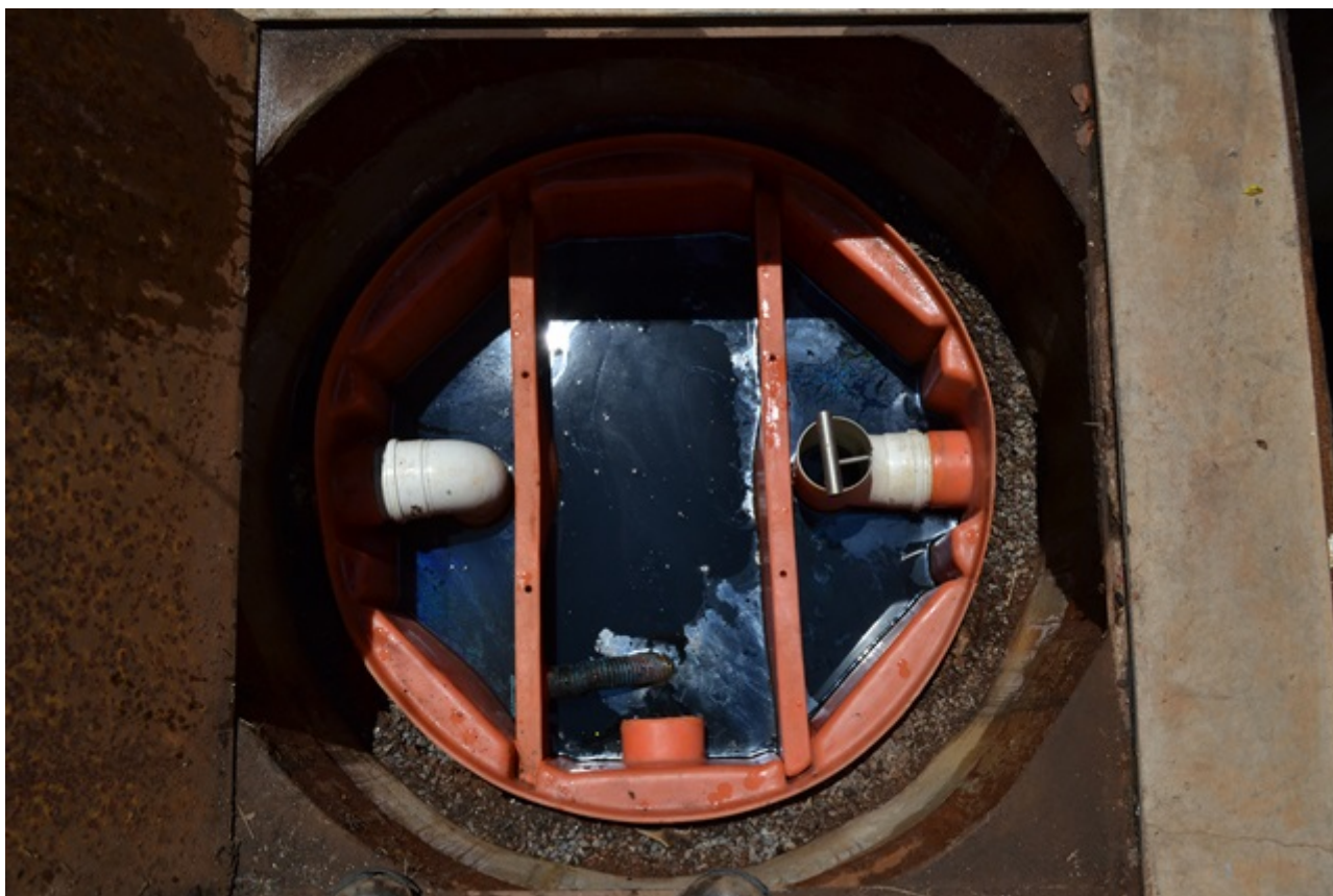
Figura 25: Caixa separadora de água e óleo S.A.O. do lava-jato. Esta área está desativada.
