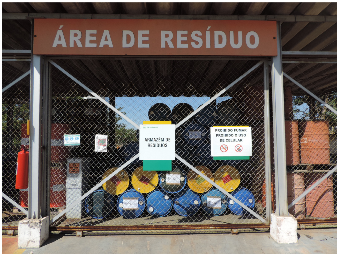
Figura 14 - Armazém de resíduos, impermeabilizado, e cercado por grelhas direcionadas a caixa seca e sistema separador de água e óleo - SSAO (2).
