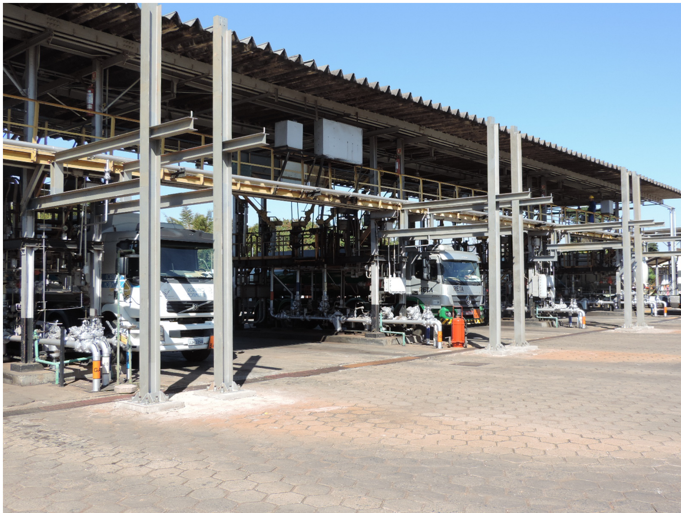
Figura 02 - Plataforma de carregamento de caminhão tanque - CT, o local passará por reformas com ampliação da cobertura, alterações no sistema de drenagem oleosa e instalação de calhas de drenagem.
