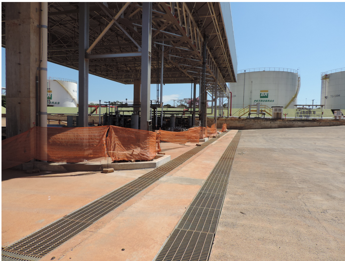
Figura 18 - Plataforma de descarga de caminhão tanque em construção.
