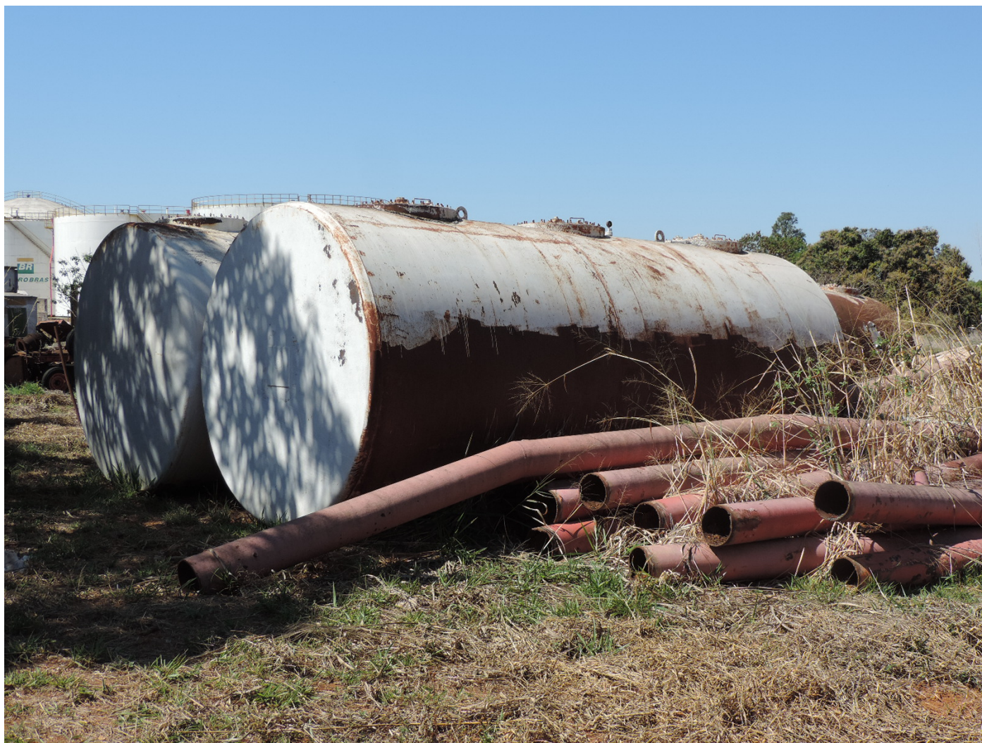
Figura 26 - Tanques e equipamentos fora de uso.
