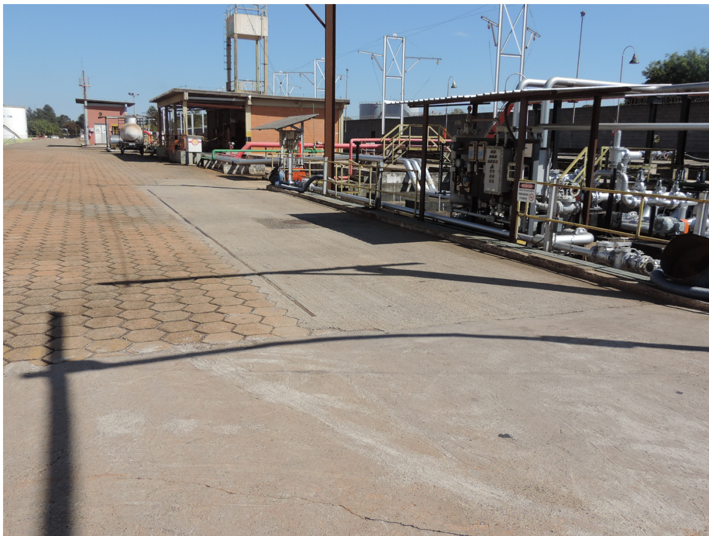
Figura 11 - Área de descarga em projeto de expansão.
