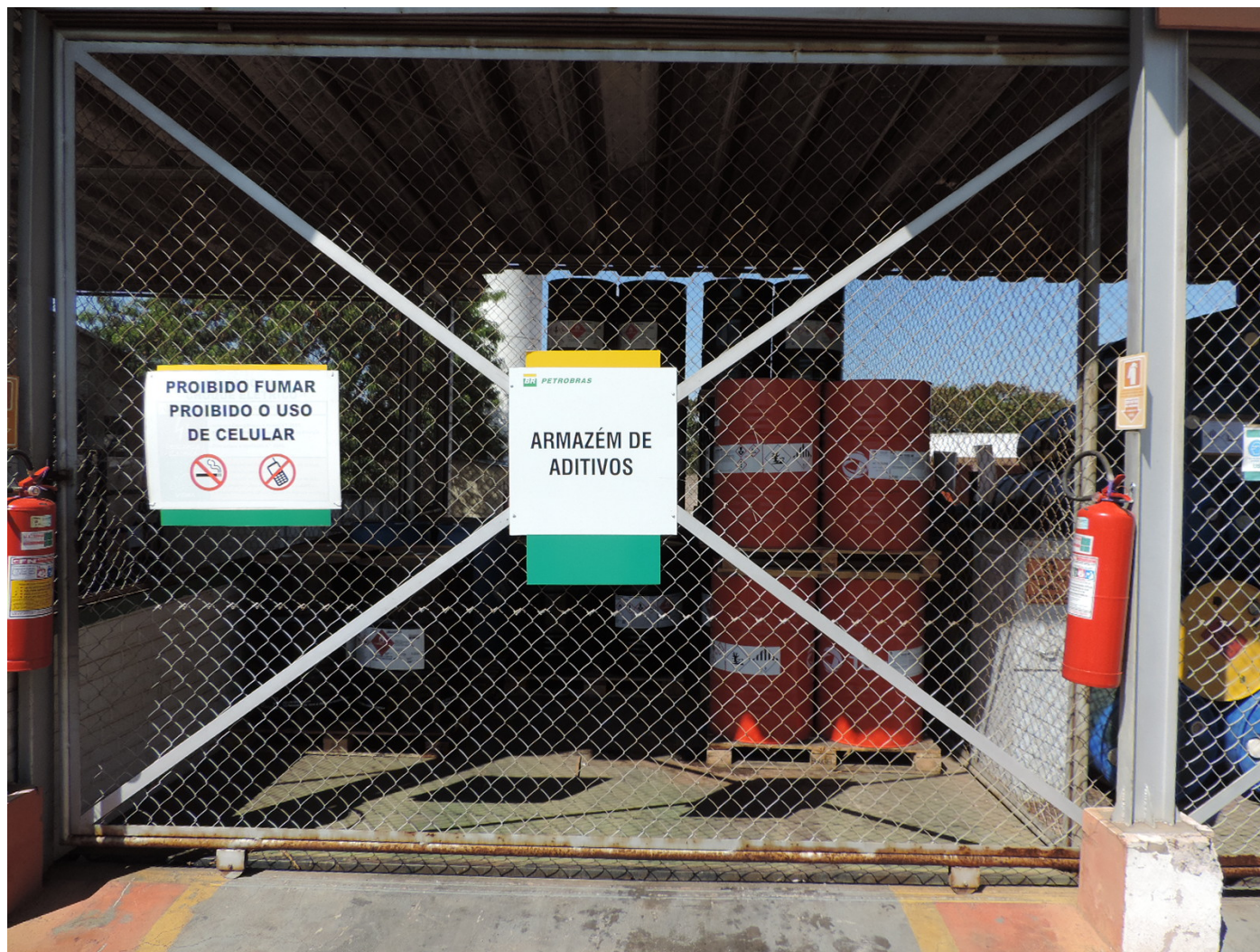
Figura 13 - Armazém de aditivos, local coberto, impermeabilizado, e cercado por grelhas direcionadas a caixa seca e sistema separador de água e óleo - SSAO (2).
