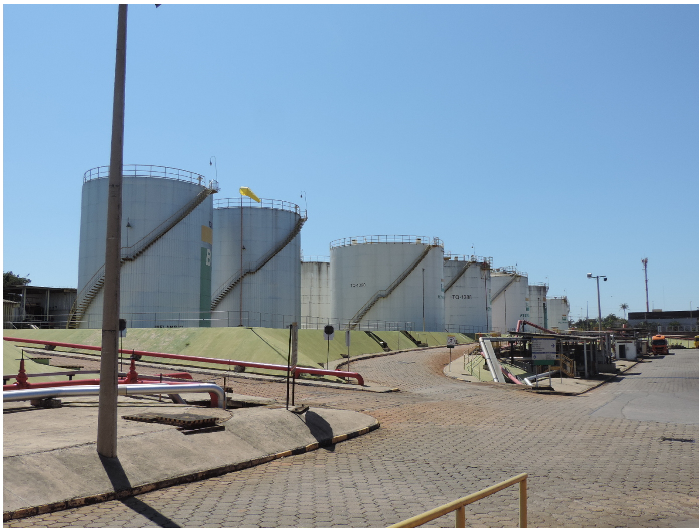
Figura 07 - Visão geral do empreendimento, tanques e casa de bombas ao fundo.
