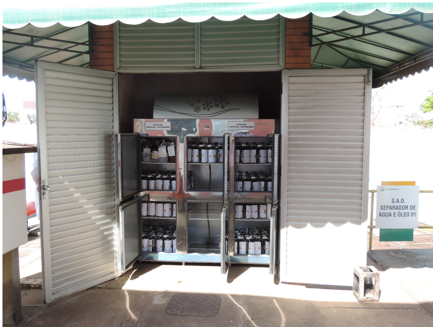
Figura 05 - Galpão onde são armazenadas amostras dos produtos em geladeira dotada de bacia de contenção.
