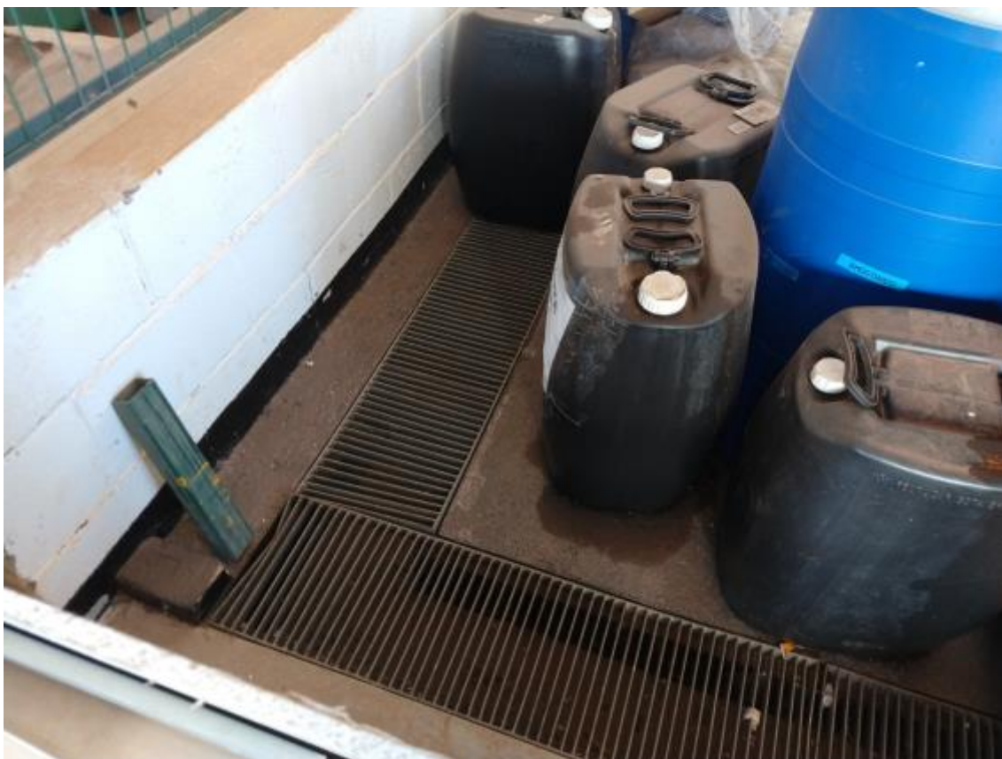
Figura 7 - Canais de drenagem que levam ao tanque de abastecimentos dos materiais químicos.
