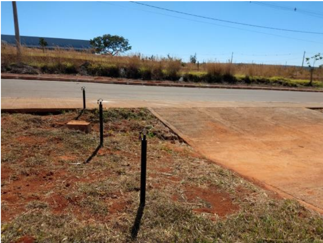
Figura 15 - Suporte para a mangueira do caminhão em local não pavimentado.
