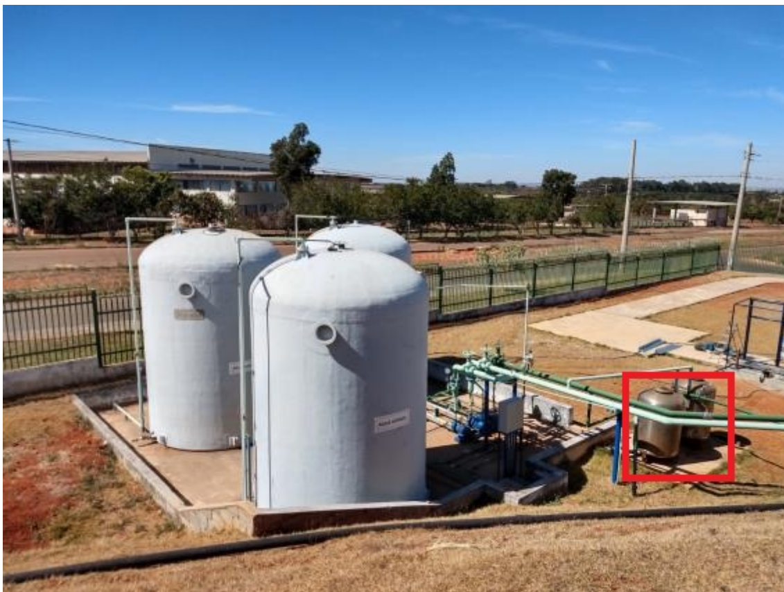
Figura 2 - Antiga área do clorador em destaque vermelho.
