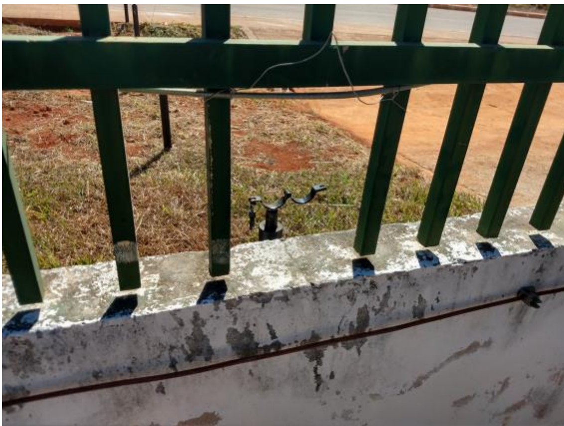
Figura 13 - Grade por onde a mangueira do caminhão passa.
