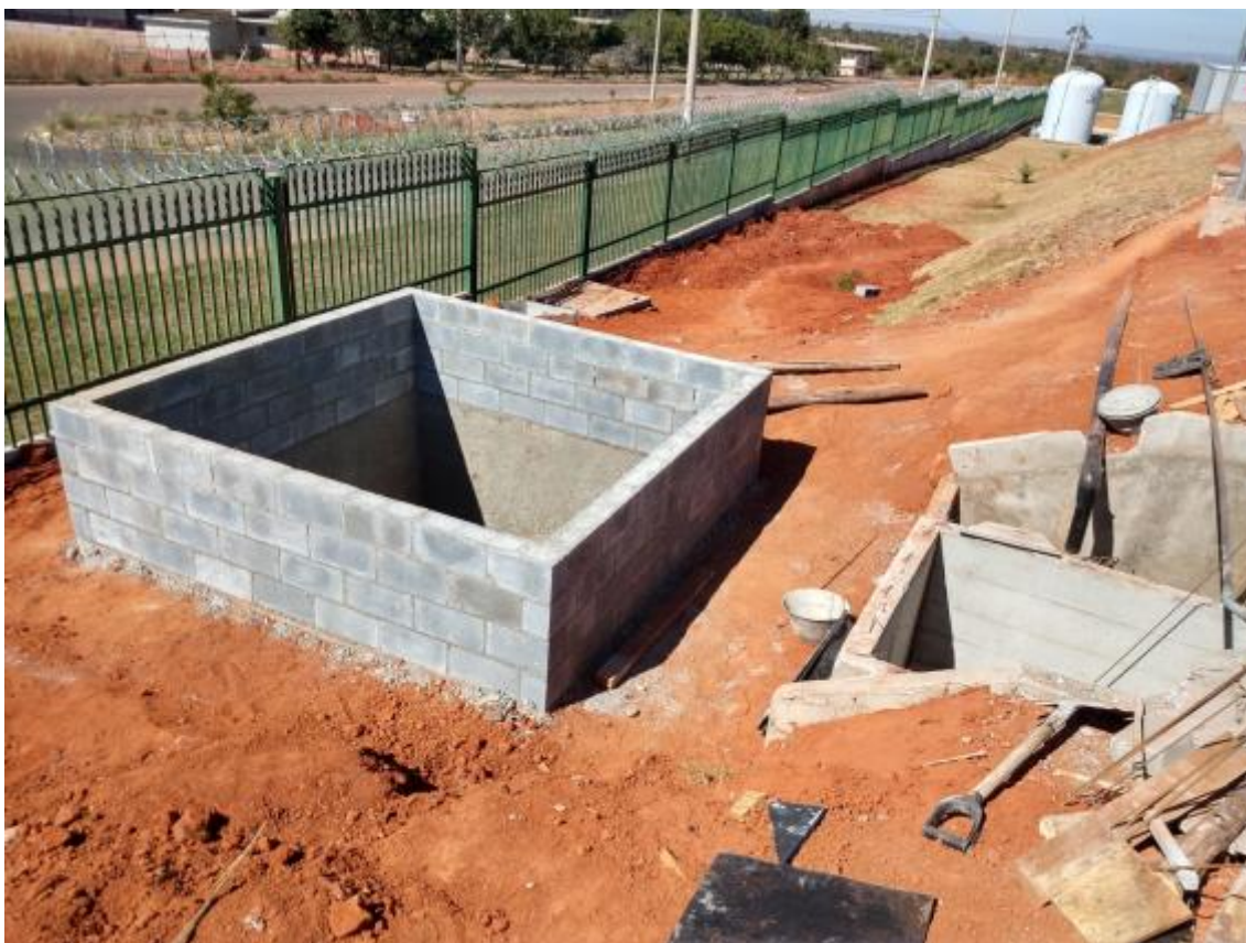
Figura 11 - Construção da nova caixa de passagem dos hormônios ao lado esquerdo.
