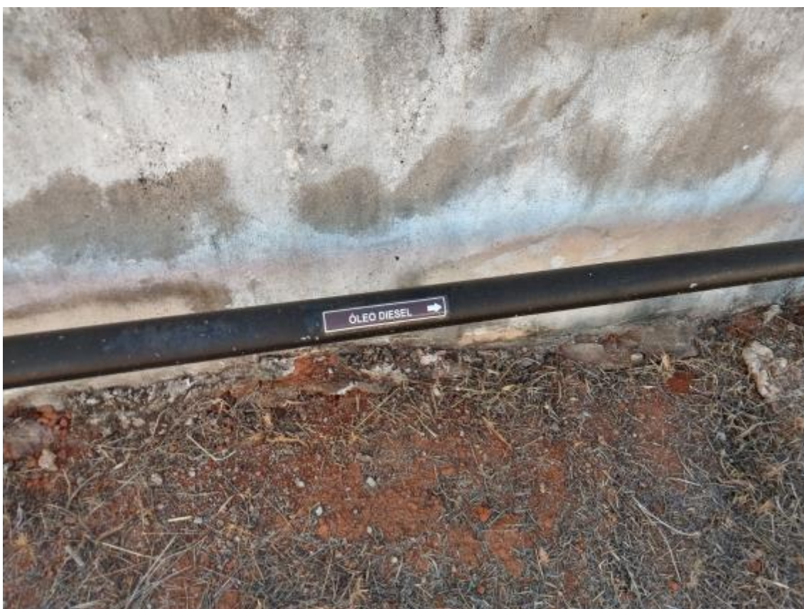
Figura 4 - Sinalização da tubulação metálica de combustível.
