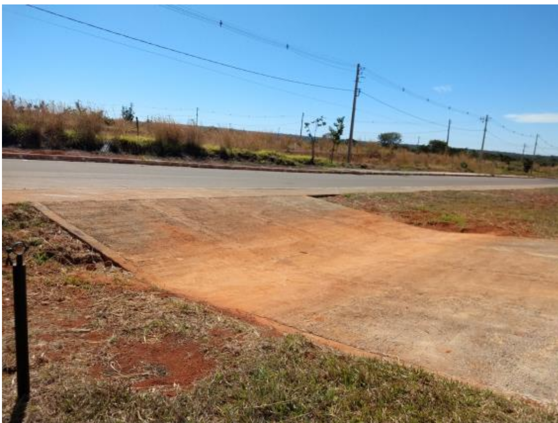
Figura 12 - Área pavimentada destinada ao recolhimento de resíduos.
