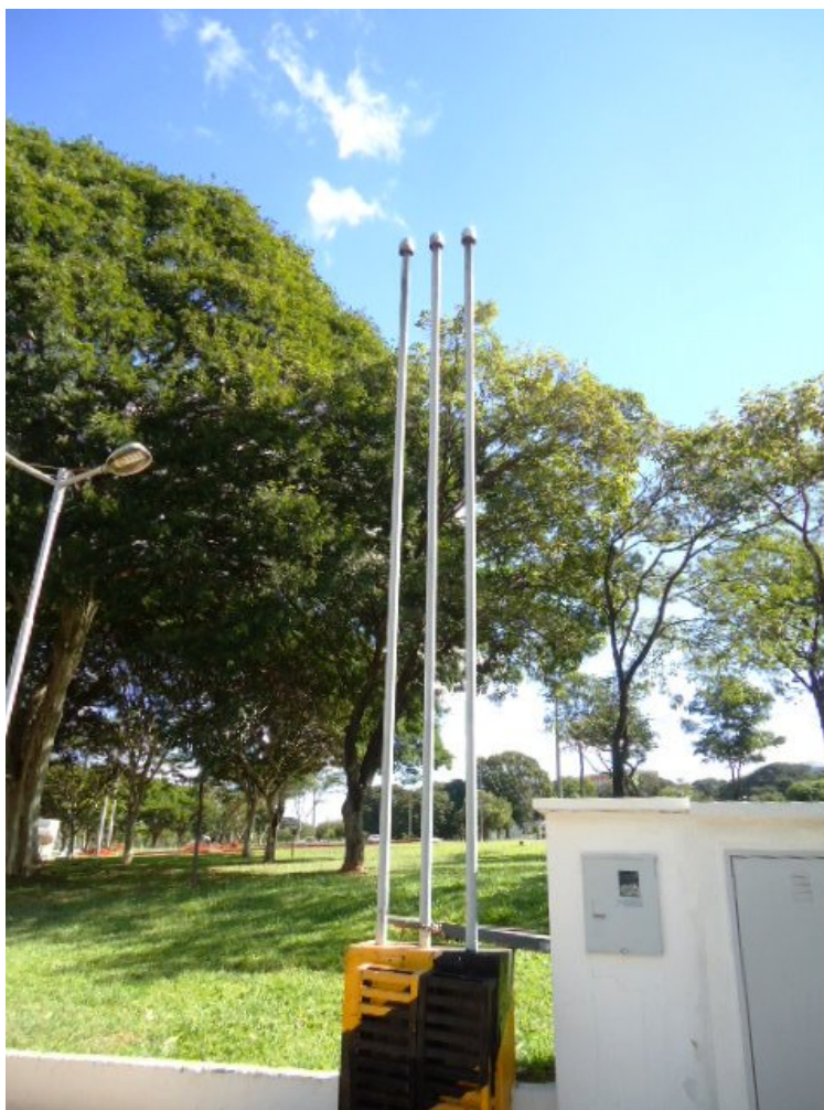
Figura 9 - Respirios com terminal corta-Chamas nº2.
