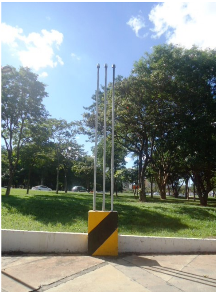
Figura 8 - Respiros com terminal corta-Chamas nº1.
