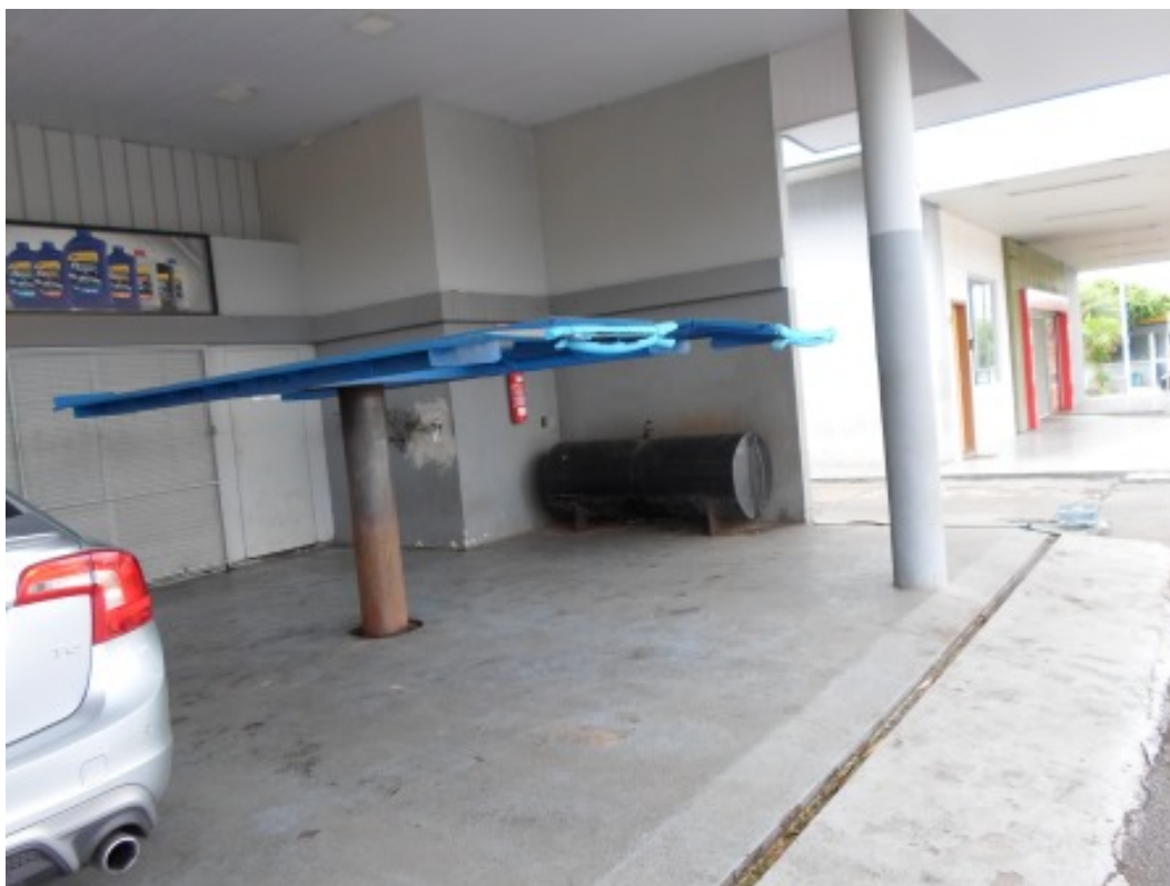
Figura 30 - Tanque de OLU, localizado na área de lubrificação de veículos não atendida por sistema separador de água e óleo.
