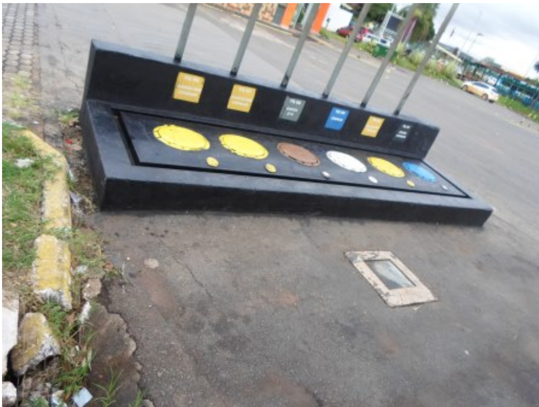
Figura 10 - Descargas seladas a distância, circundadas por canaletas destinados ao SAO.
