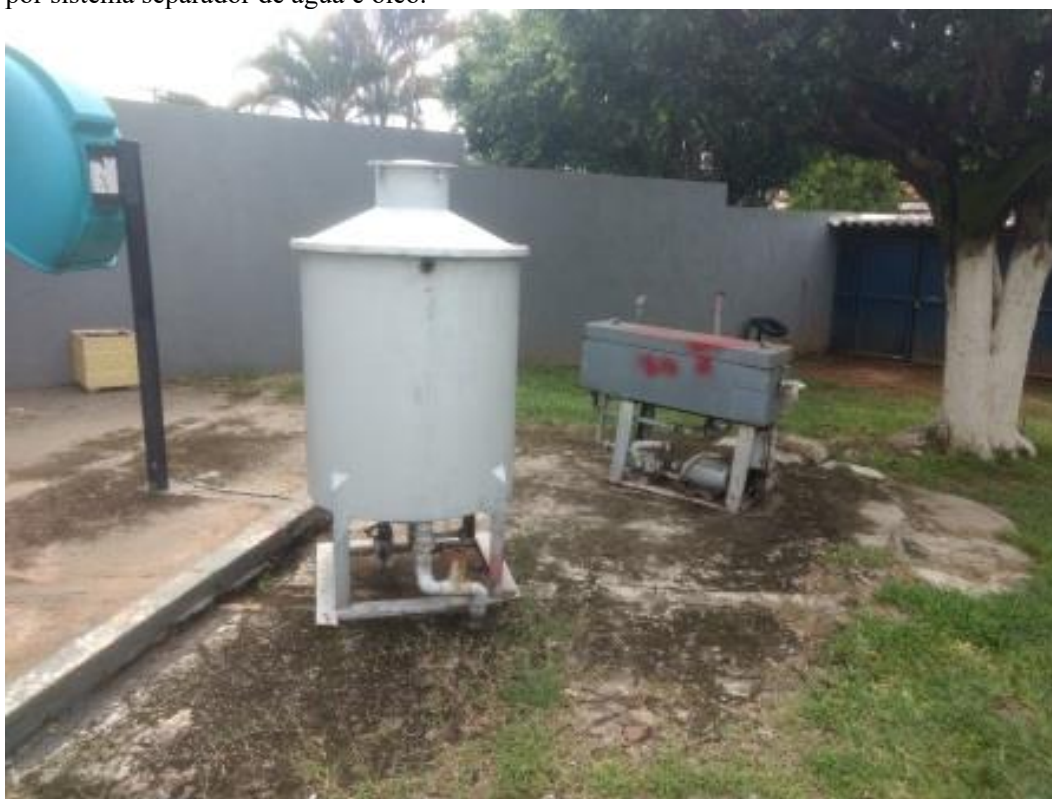
Figura 31 - Antigos filtros de diesel aguardando destinação final.
