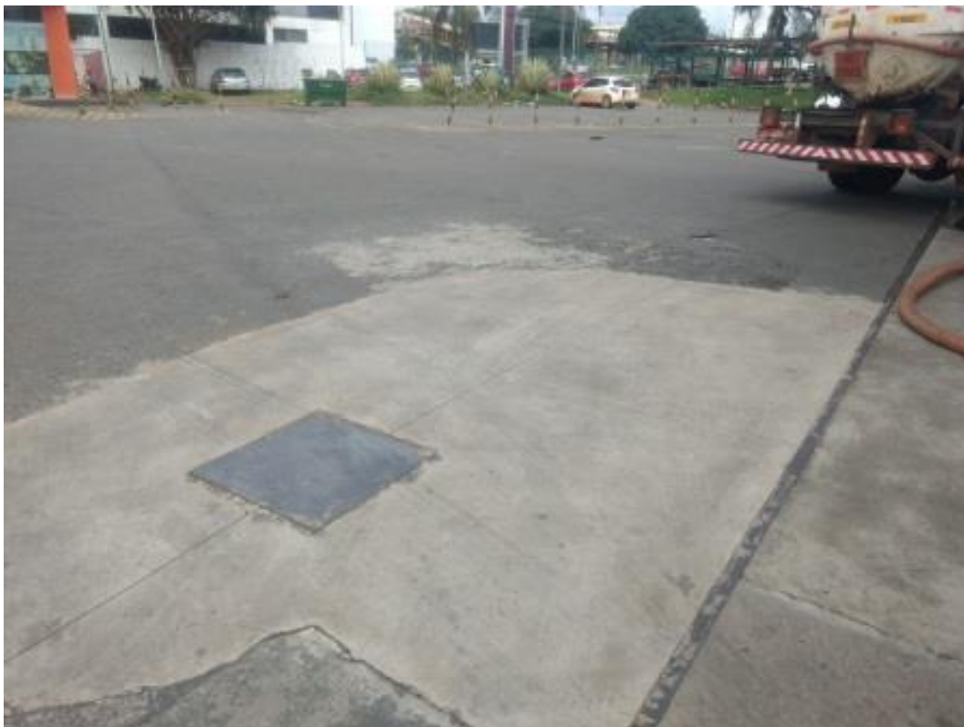
Figura 28 - Área do antigo sistema separador da pista de abastecimento.
