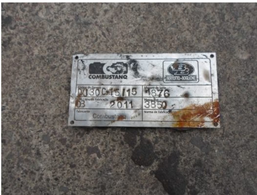
Figura 8 - Placa de identificação de um dos tanques, observa-se o ano de fabricação de 2011.
