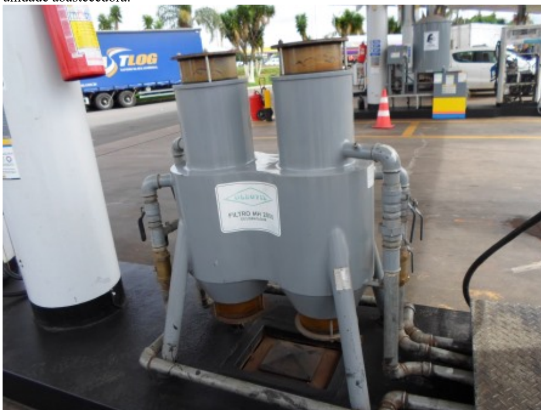
Figura 15 - Segundo filtro de diesel.
