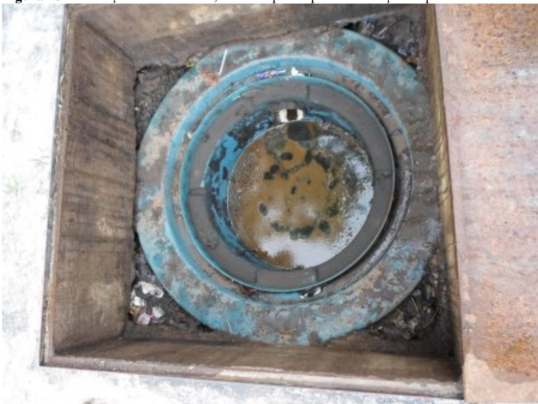
Figura 19 - Módulo de separação de sólidos (gradeador) - Pista de Abastecimento.
