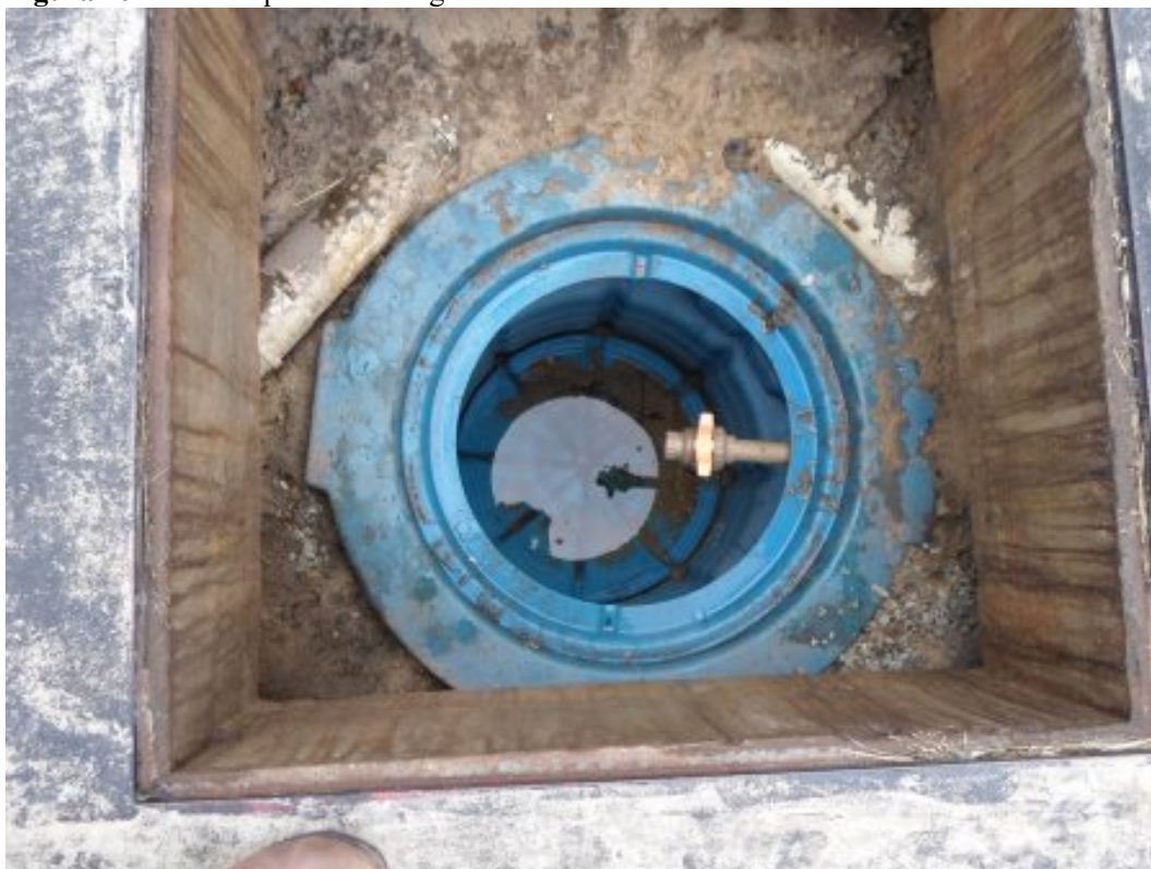
Figura 21 - Módulo para coleta de óleo - Pista de Abastecimento.
