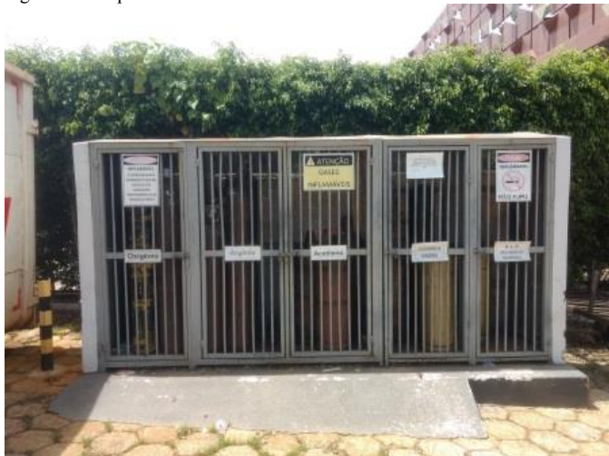
Figura 16 - Local de armazenamento de gás, inclusive GLP.
