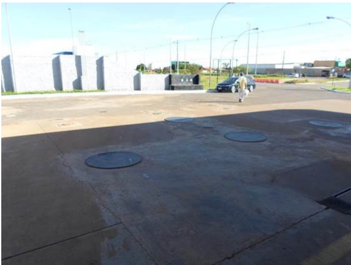
Foto 12 – Área de tancagem, evidenciando a presença de dois tanques plenos e 1 bipartido.
