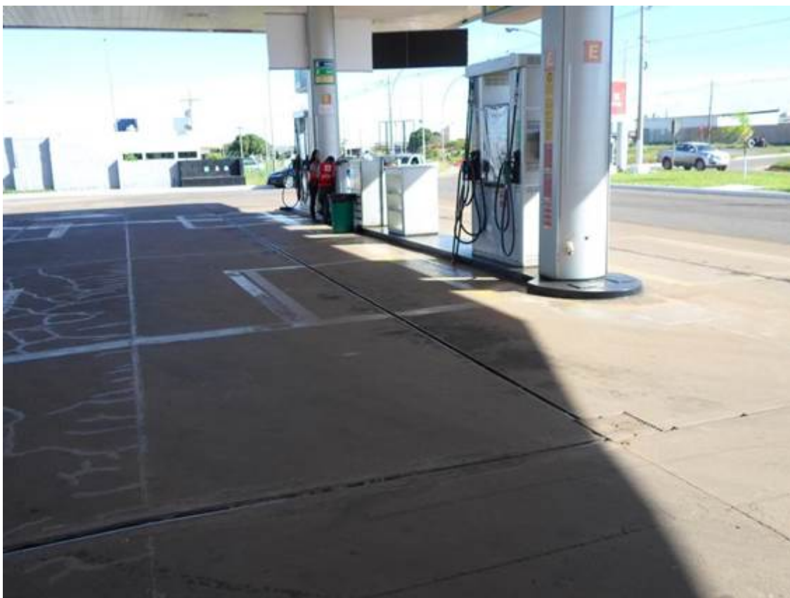
Foto 4 – Canaletes, localizados na pista de abastecimento.
