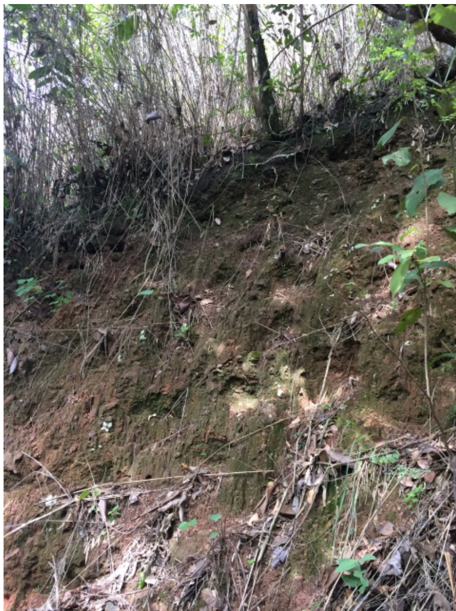
Foto 03: Talude posicionado adjacente à casa da fonte.
