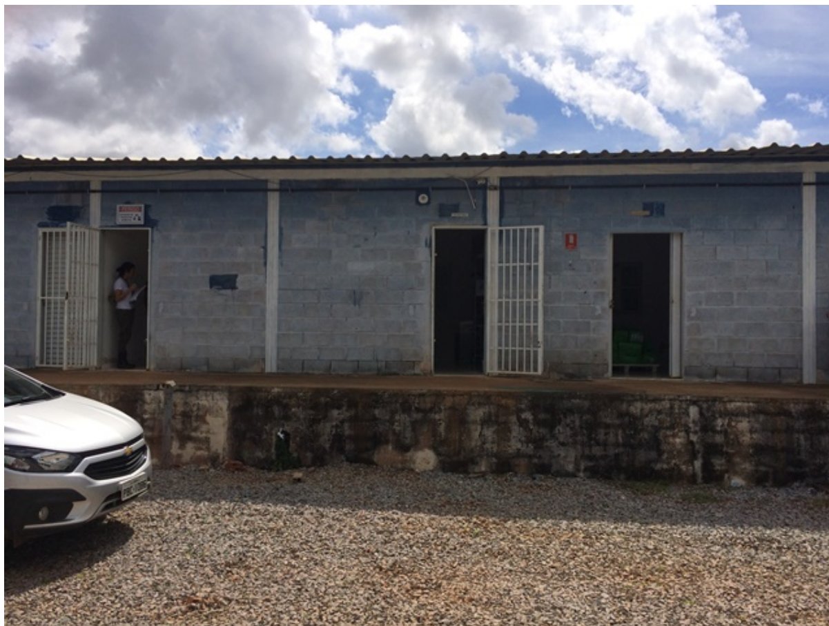
Foto 05: Salas destinadas ao estoque de produtos perigosos, almoxarifado e escritório.
