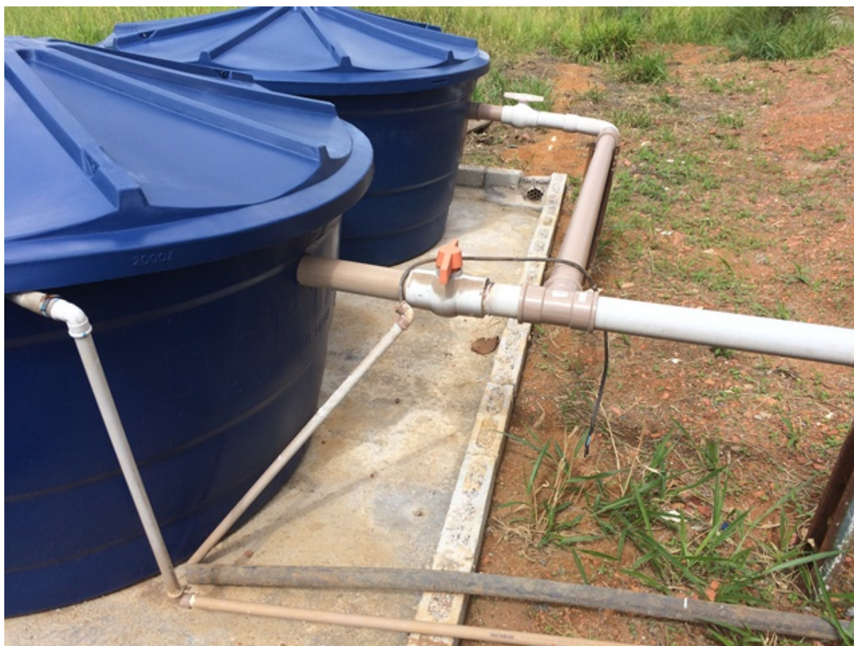
Foto 06: Sistema de decantação de efluentes líquidos, após modificação.
