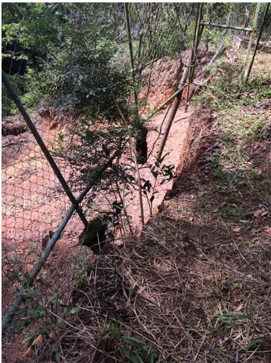
Foto 04: Encosta localizada próxima à casa da fonte, abaixo dela.
