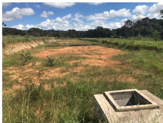
Foto 02 - Dispositivo de Saída da Bacia de Drenagem.
