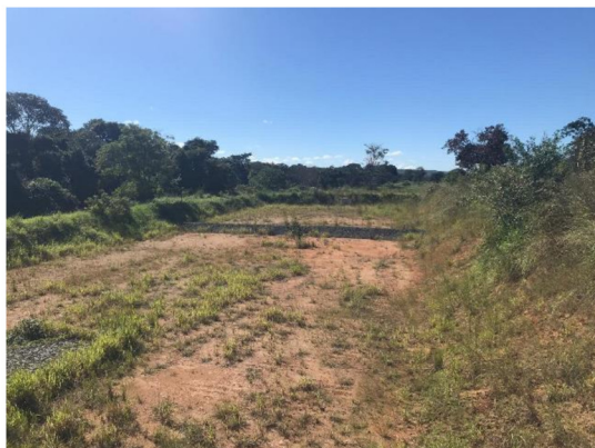
Foto 01 - Bacia de Drenagem.
