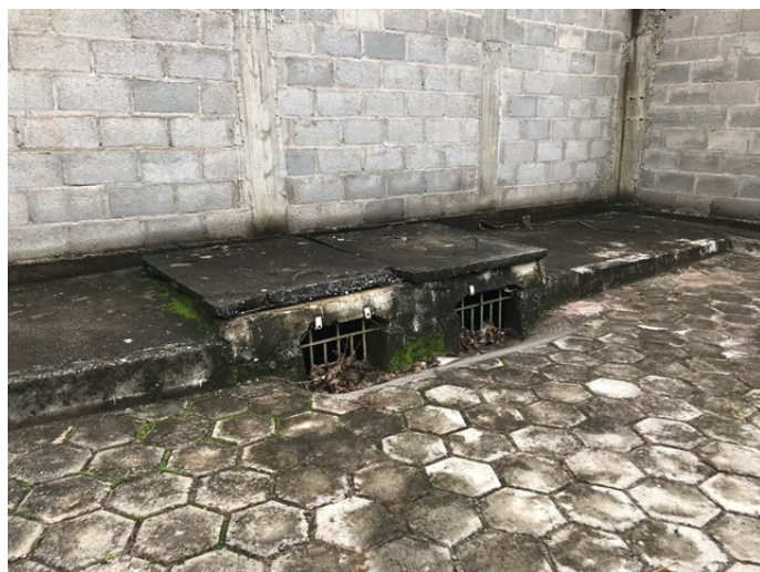
Foto 3 - Pavimento Intertravado e boca de lobo
