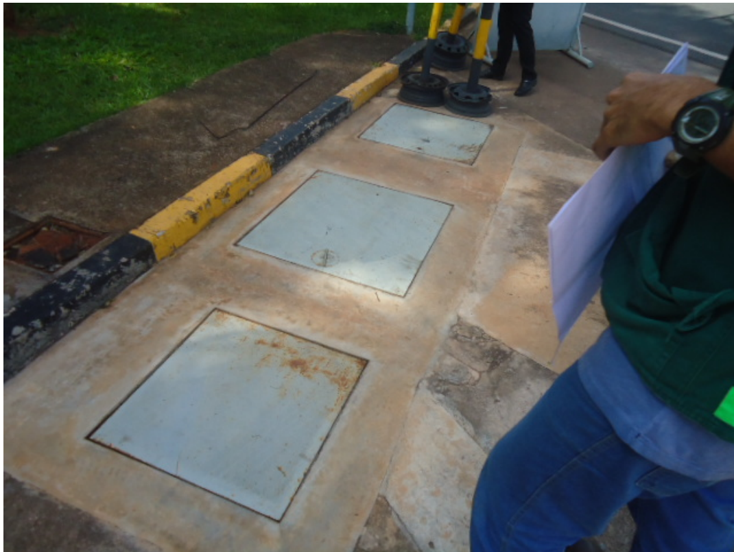
Foto 10 – Visão geral do SAO da pista de abastecimento
