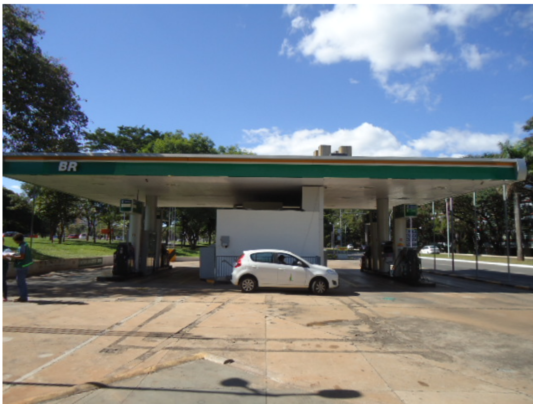
Foto 1 – Visão geral do posto e das 2 (duas) pistas de abastecimento
