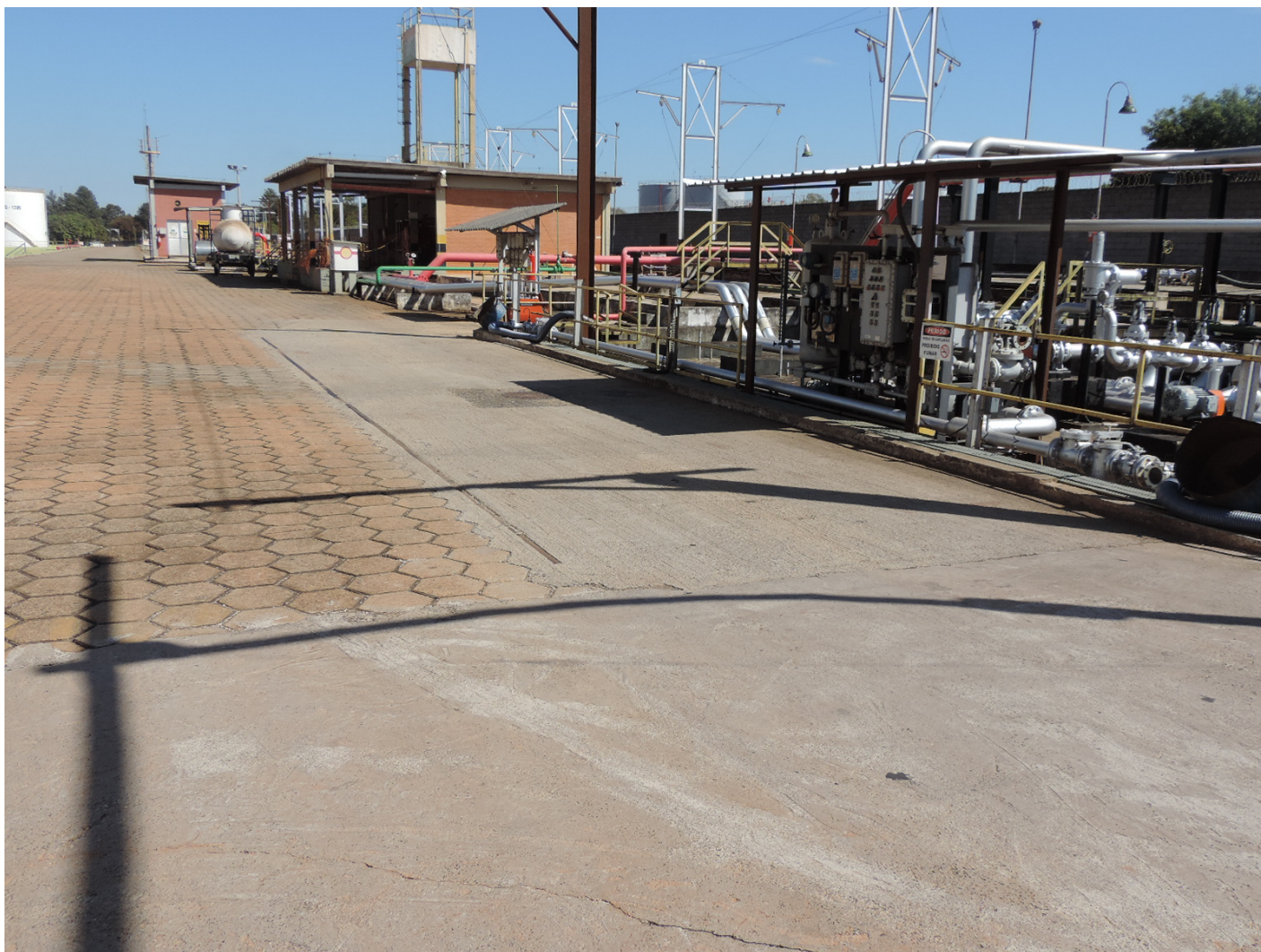
Figura 03 - Área de descarga em projeto de expansão.
