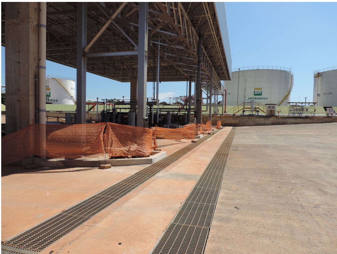
Figura 05 - Plataforma de descarga de caminhão tanque em construção.
