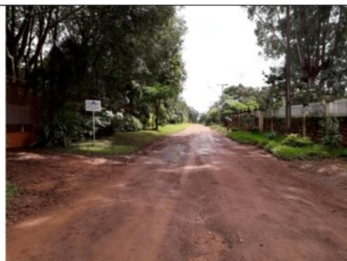
Foto 7 – Após avançar aproximadamente 400 metros, o traçado prevê o encontro com via de terra já consolidada a ser asfaltada.
