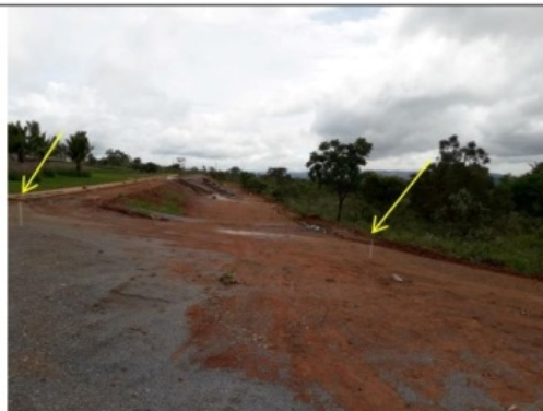
Foto 28 – Estacas marcando a base da rodovia em frente à entrada do Parcelamento de Solo Urbano Jardins Geneva.
