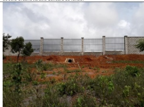
Foto 29 – Muro e dispositivo de drenagem do Parcelamento de Solo Urbano Jardins Geneva.
