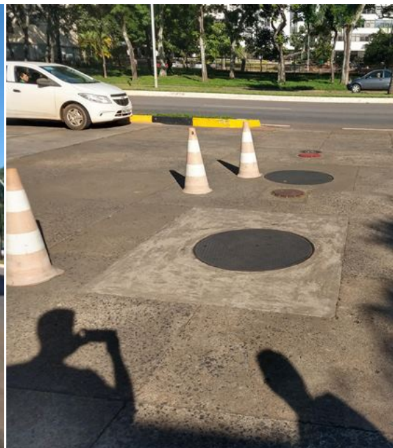
Foto 2. tanque bicompartimentado na lateral da pista de abastecimento
