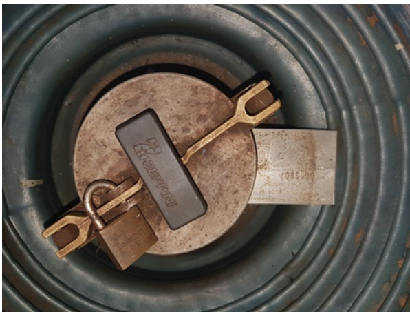
Foto 2. Descarga selada sobre o tanque
