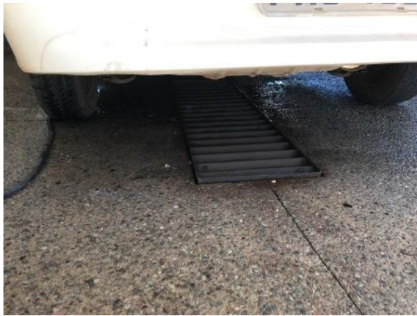
Foto 37: Detalhe caixa de areia central na lavagem de veículos.
