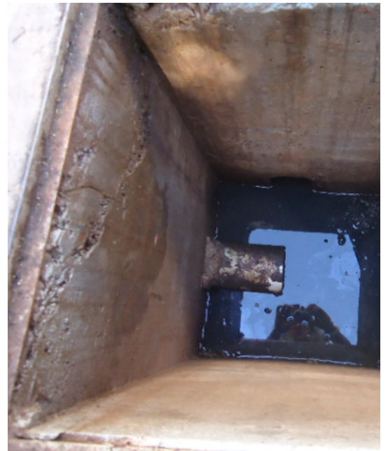
Foto 42: Caixa coletora de óleo em concreto do SAO da pista de abastecimento e área de descarga à distância.
