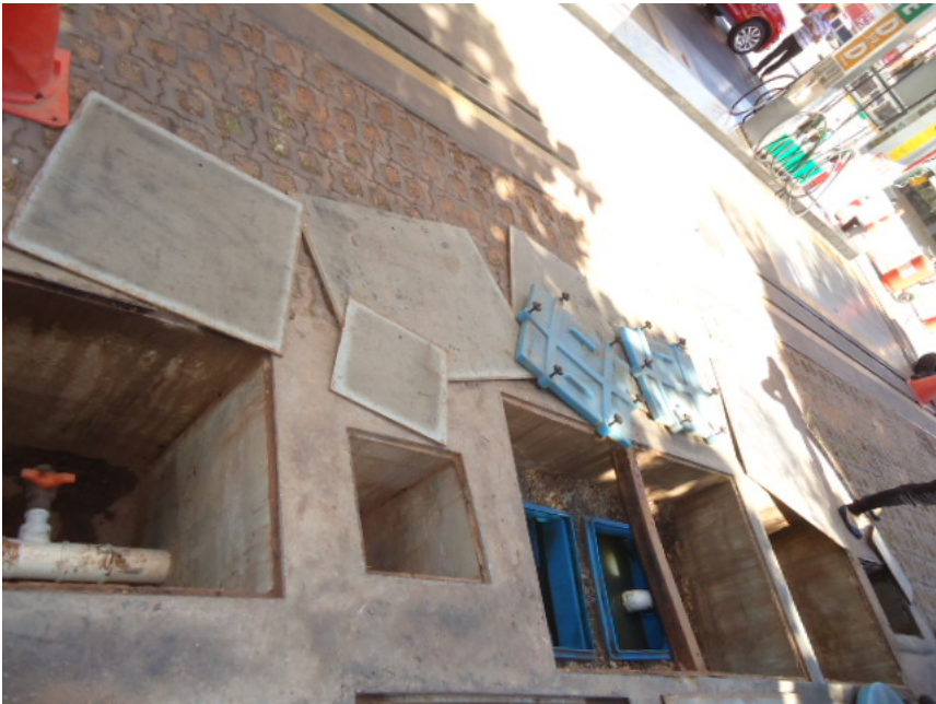
Foto 49: Detalhe do SAO da pista de abastecimento, área de lubrificação de veículos e área de descarga à distância.
