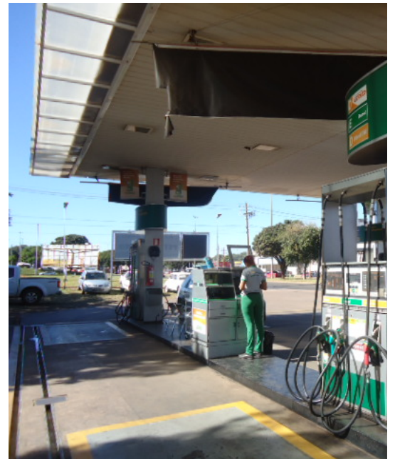
Foto 5: Pista de abastecimento contendo 2 ilhas, com unidade
