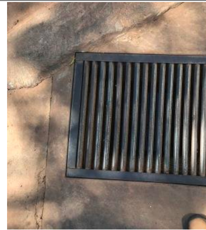
Foto 38: Detalhe caixa pluvial na entrada da l
