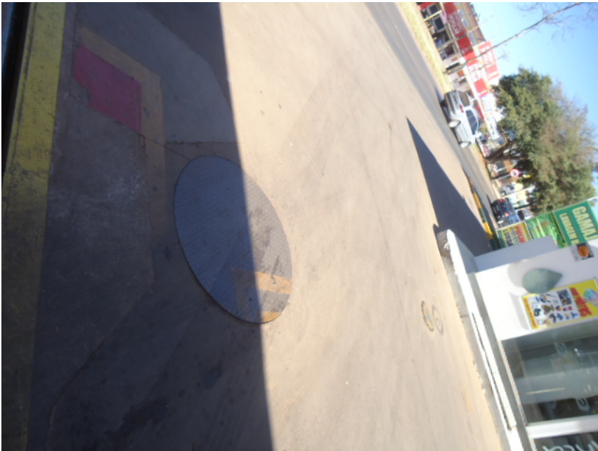
Foto 16: Localização dos tanques subterrâneos de armazenamento de combustíveis – Tanque Pleno.
