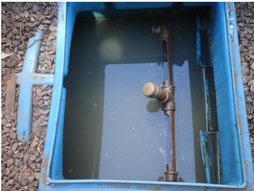
Foto 43: Caixa separadora em polietileno do SAO da pista de abastecimento, área de lubrificação de veículos e área de descarga à distância.
