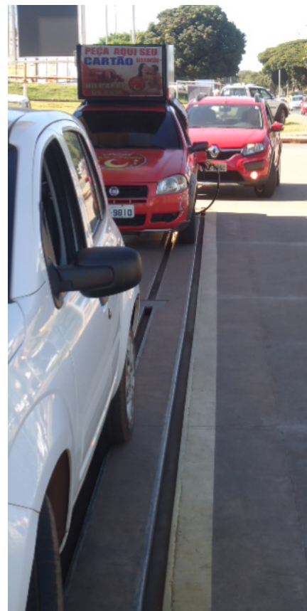
Foto 3: Pista de abastecimento com piso impermeável e circundado por canaleta. Como pode ser visto o efluente não abrangem toda a área necessária. Como pode ser visto o efluente é direcionado para os canaletes de água pluvial.
