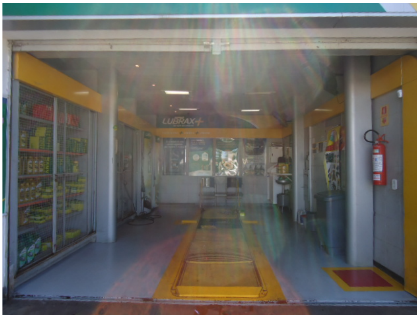
Foto 25: Área de lubrificação de veículos com piso impermeável em bom estado de conservação, vala central, cobertura e canaleta na entrada.
