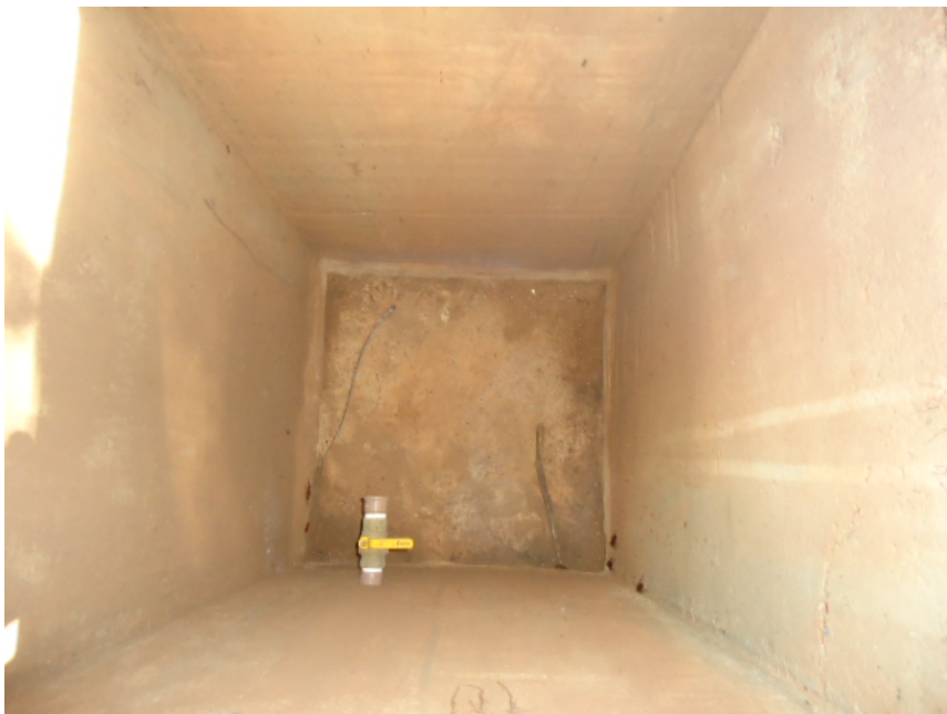
Foto 57: Caixa coletora de óleo em concreto do SAO exclusivo da atividade de lavagem de veículos.
