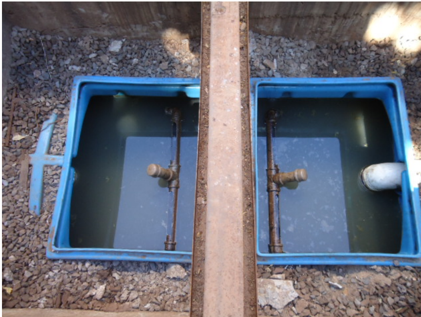
Foto 43: Caixa separadora em polietileno do SAO da pista de abastecimento, área de lubrificação de veículos e área de descarga à distância.
