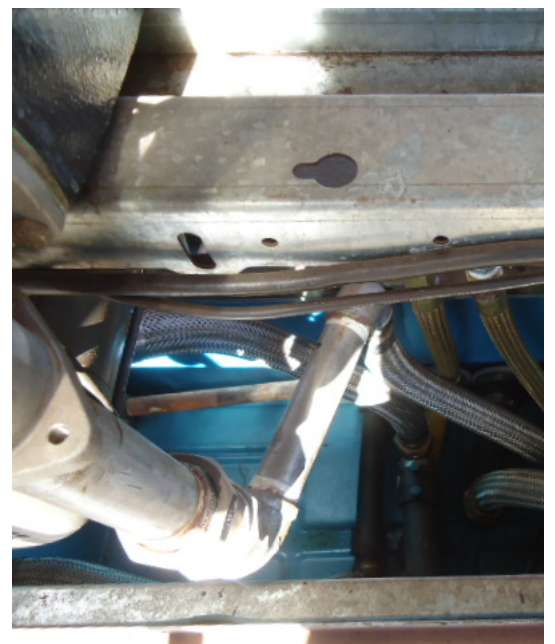
Foto 7: Unidade de filtração de diesel em área fora da pista de abas: circundado por canaleta. Além disso, as conexões e tubulações são
