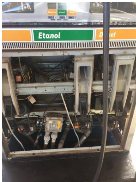
Foto 6: Unidade de abastecimento de diesel com câmara de contenção.
