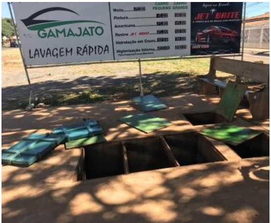
Foto 50: Detalhe da caixa de areia em concreto do SAO da pista de abastecimento e área de descarga à distância.
