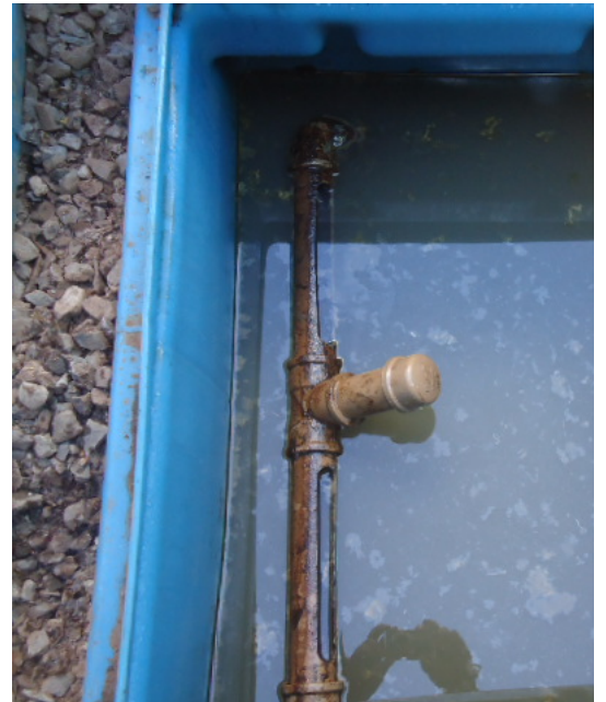
Foto 44: Detalhe da caixa separadora em polietileno.
