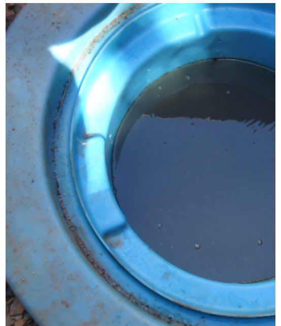
Foto 44: Detalhe da caixa separadora em polietileno.
