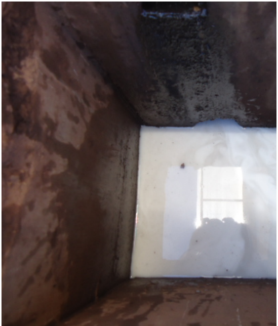
Foto 50: Detalhe da caixa de areia em concreto do SAO da pista de abastecimento e área de descarga à distância.
