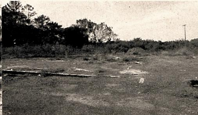
Figura 3: Vista parcial das fundações existentes.
