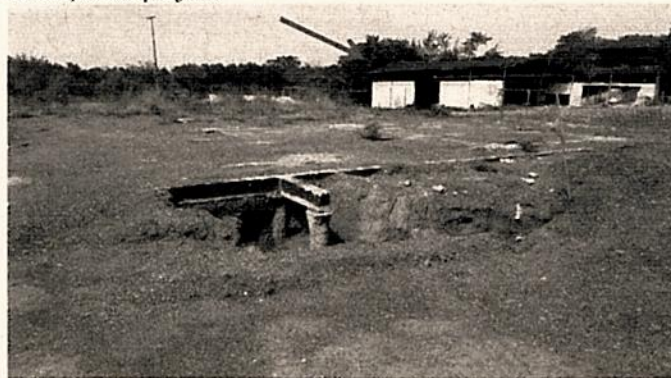
Figura 6: Vista parcial da fundação existente (cintas e estacas) à frente e galpão do centro de triagem que será desativado indicado pela seta vermelha.
