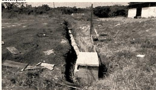
Figura 4: Rede de drenagem a ser retirada devido à alteração de projeto.
