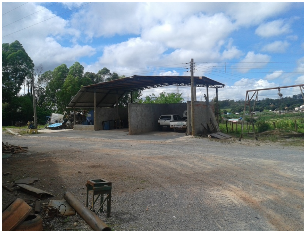
Foto 7- Galpão para manutenção de máquinas e equipamentos. Área de abastecimento com piso impermeável e circundada por canaletes. Tanque aéreo em local coberto e com bacia de contenção.
