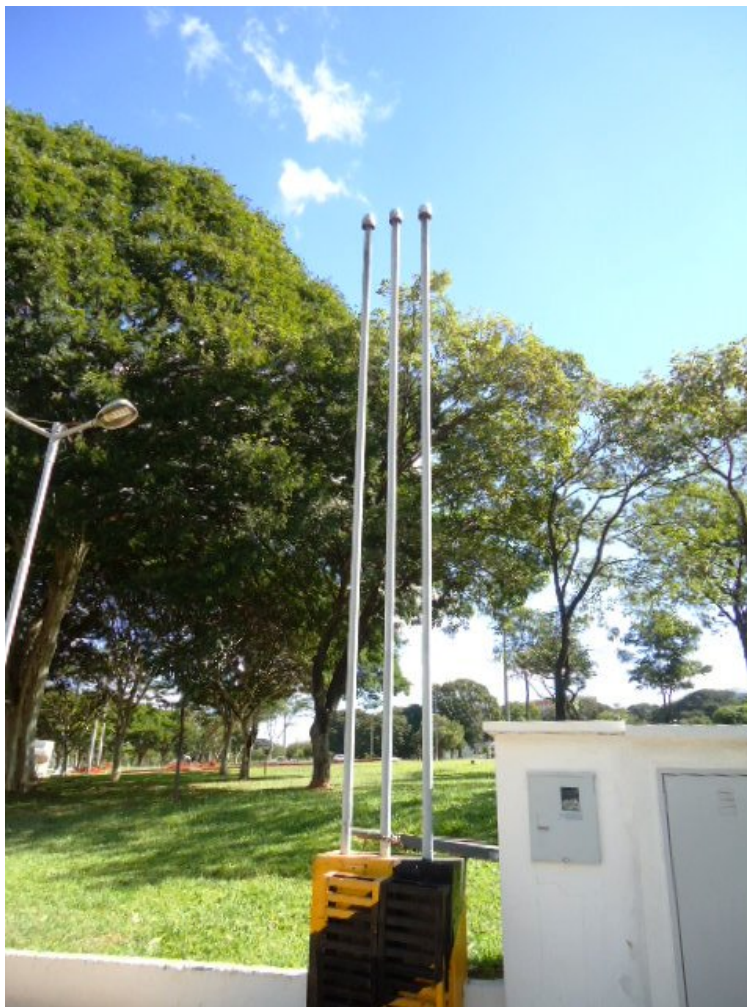
Figura 9 - Respirios com terminal corta-Chamas nº2.
