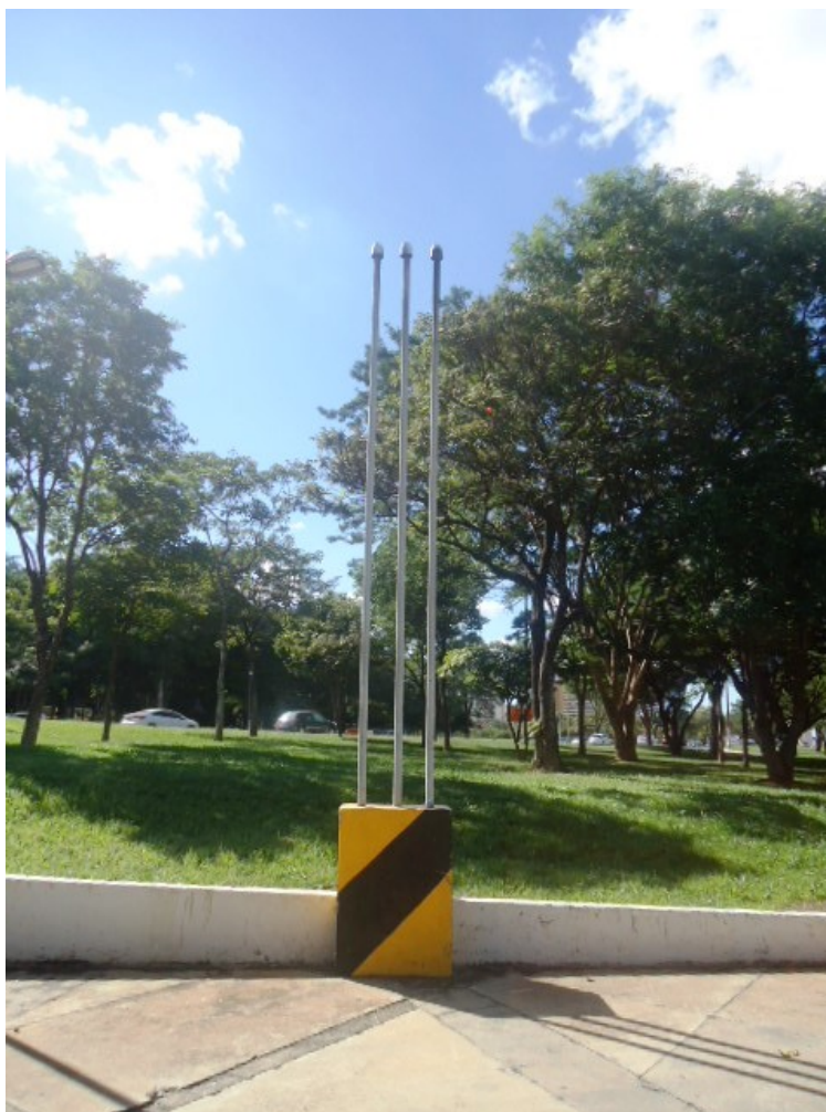
Figura 8 - Respiros com terminal corta-Chamas nº1.
