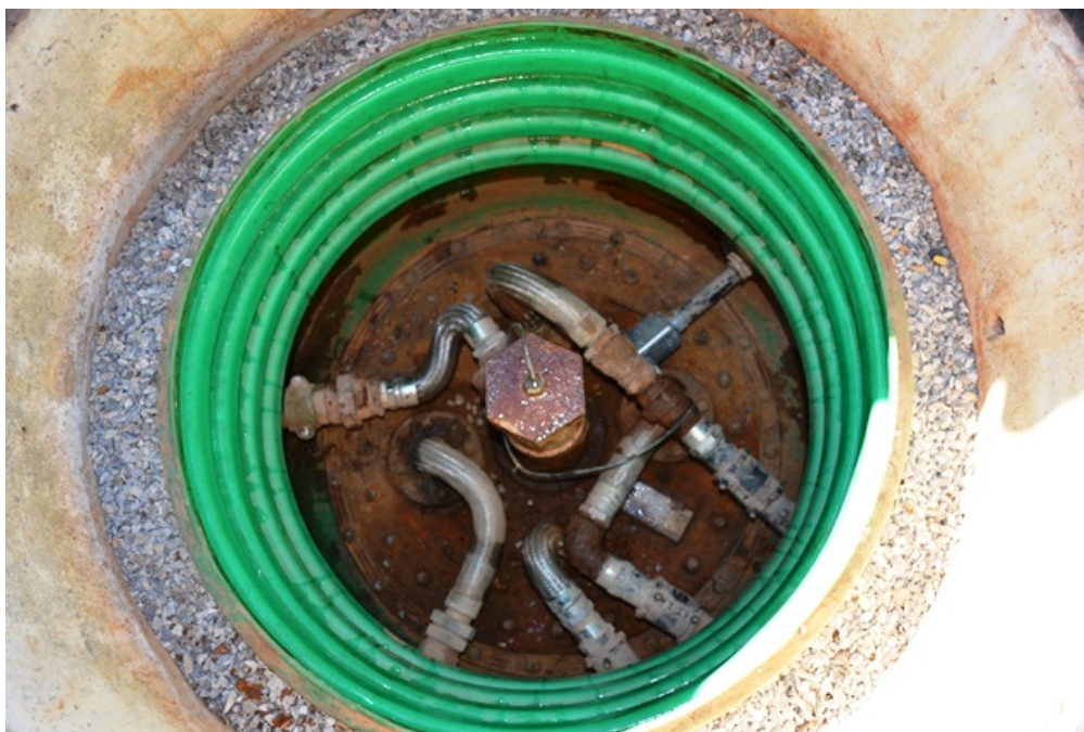
Figura 10 - Aspecto da Câmara de contenção ( sump ) na boca de visita do tanque com controle eletrônico de estoque, tubulação metálica flexível, tubulação subterrânea em PEAD e flanges de vedação. Observa-se a corrosão na tampa do tanque necessitando de manutenção operacional constante conforme exige a tabela 1 da ABNT NBR 15594-3:2008.
