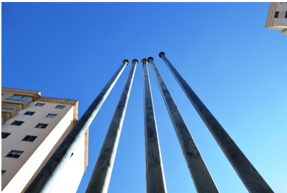
Figura 8 - Respiros com terminal corta chamas. Observa-se que os 2 (dois) respiros estão bastante próximos.
