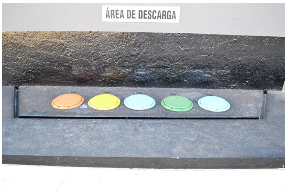
Figura 13 - Descarga selada à Distância. Observa-se que o dispositivo é circundado por canaletos direcionados ao SAO exclusivo da pista de abastecimento.
