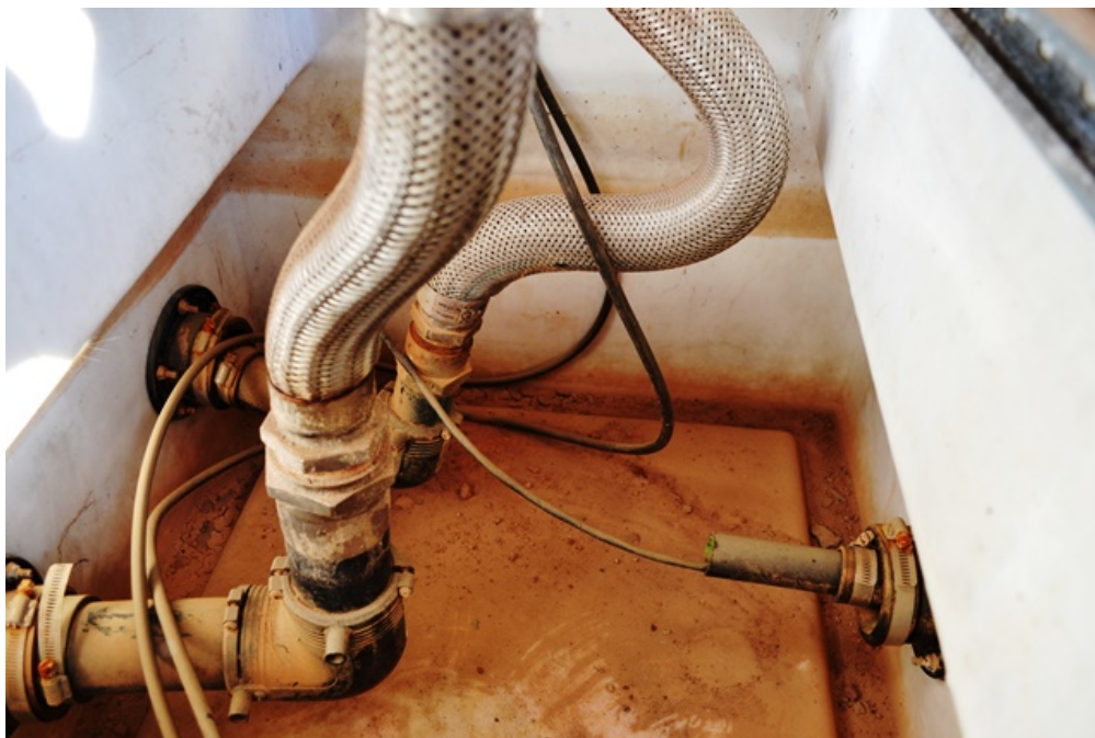
Figura 4 - Detalhe interno da Câmara de contenção de uma das Unidades Abastecedoras do SASC. Observa-se que a tubulação esta totalmente contida no dispositivo de segurança. Observa-se que
