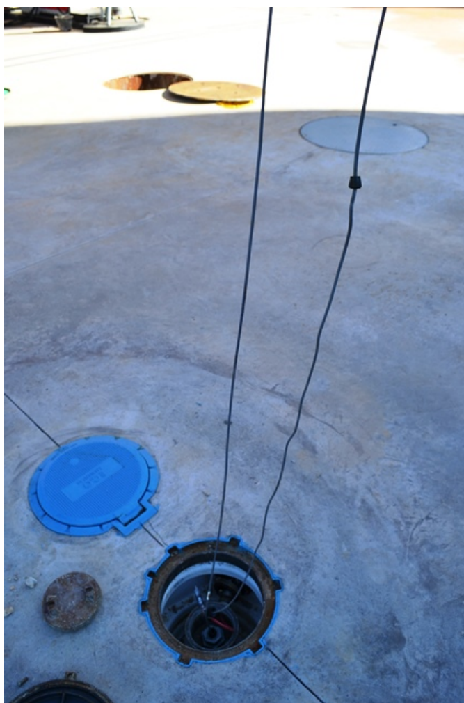
Figura 15 - Verificação do Monitoramento do Interstício.
