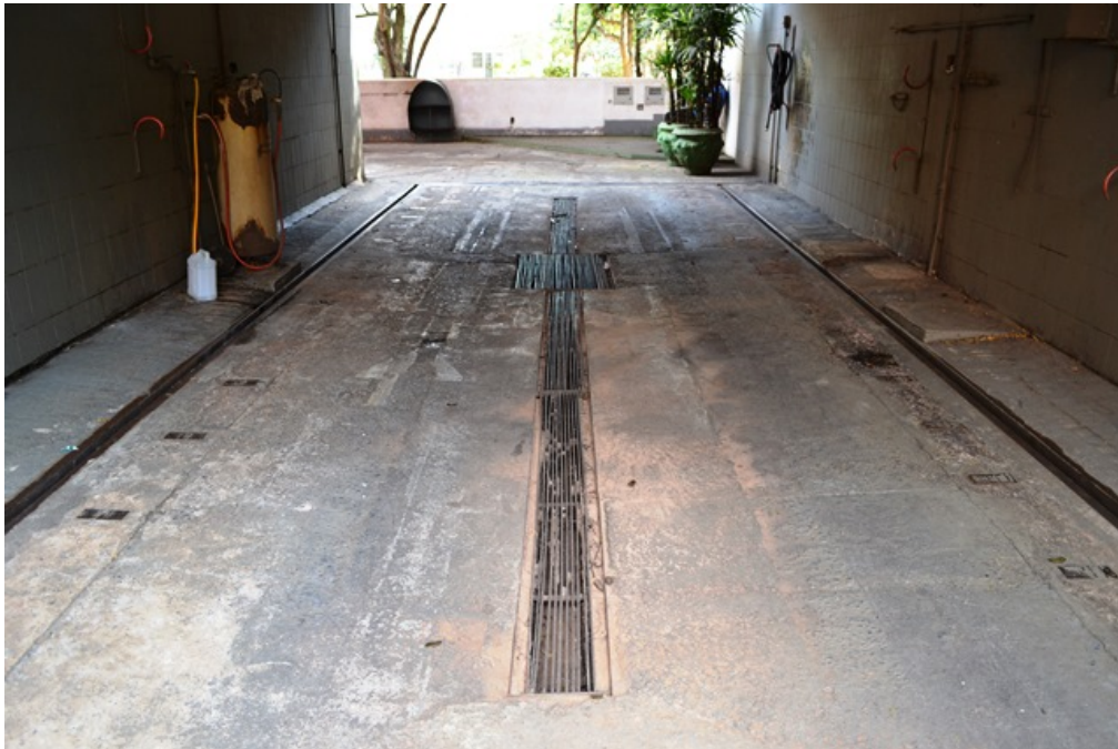
Figura 17 - Aspecto da caixa de areia central da área de lavagem de veículos. Observa-se o caimento da superfície da pista.
