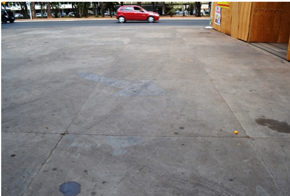
Figura 14 - Vista do local destinado para a instalação dos 3 (três) SASC conforme informa à Planta do Sistema de Drenagem Oleosa, doc Sei 9822871.
