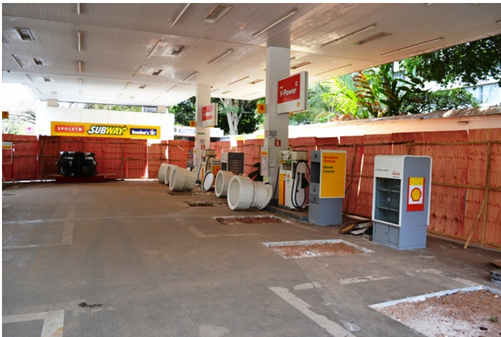
Figura 10 - Cava aberta na área do Sistema de Armazenamento de Combustíveis SASC.
