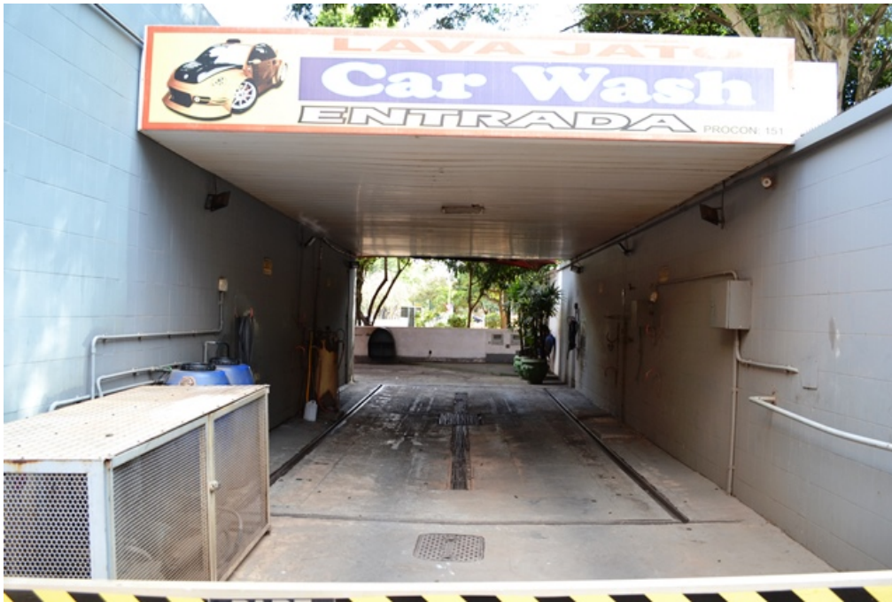
Figura 16 - Vista da área de Lavagem de Veículos, observa-se que a área possui caixa de areia central, cobertura e é cercada por canaletas com fluxo exclusivo para o SAO da área de lavagem conforme exige o parágrafo 4 art. 21 da instrução 213/2013.
