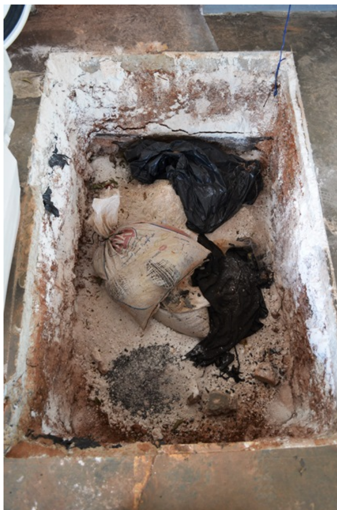
Figura 10 - Cava aberta no local de instalação do sump do tanque em um dos 7 (sete) SASC da área de tancagem.
