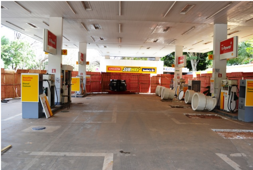
Figura 2 – Vista parcial da pista de abastecimento com as 6 (seis) Unidades Abastecedoras. Observa-se a movimentação de terra (área direita) nos locais do antigo sump do tanque e tubulações na área do fundo.
