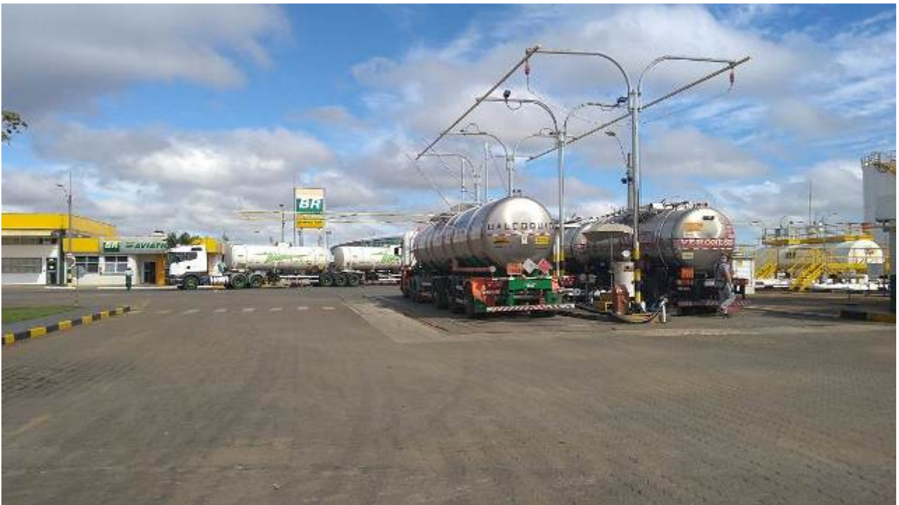
Foto 3 – Visão geral da área de recarga por caminhões tanque, que será reformada, retirando as posições de abastecimento ao fundo
