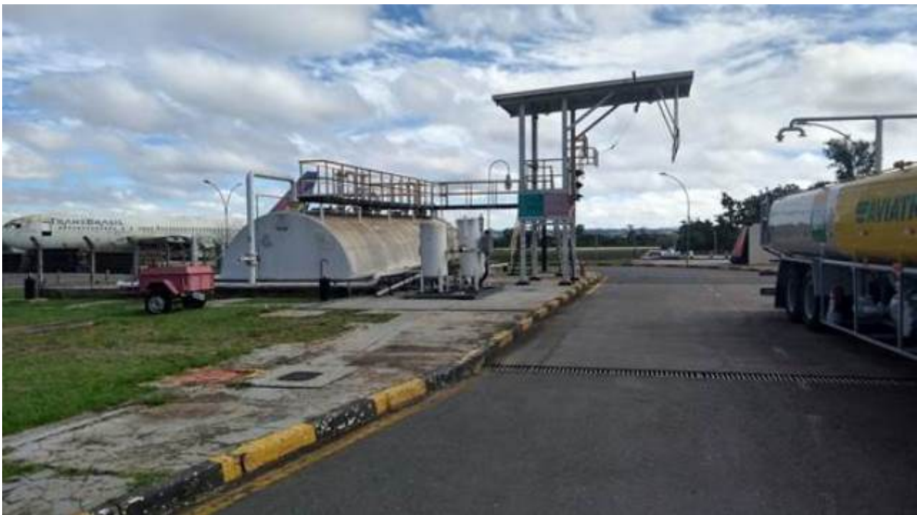
Foto 1 – Tanque semienterrado desativado e com previsão de remoção
