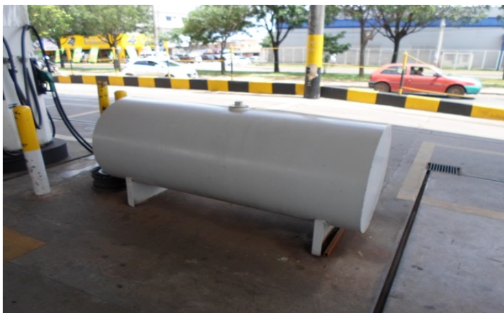
Foto 15: Local de armazenamento do OLUC.
