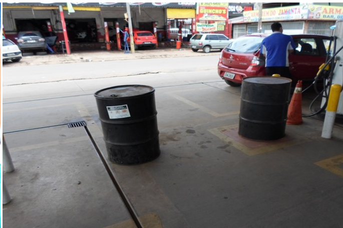
Foto 18: Tambor de óleo e demais resíduos de classe I, fora do local circulado por canaletes.
