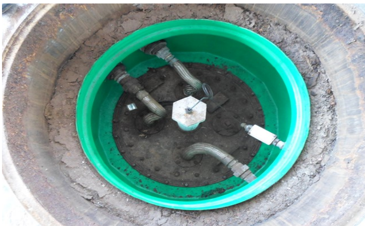
Foto 2: Visão geral da bacia de contenção.
