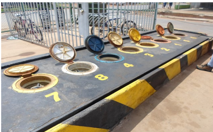
Foto 8: Descargas seladas à distância.
