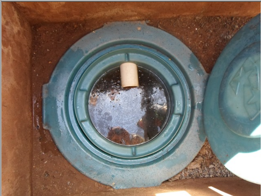
Foto 19 – Visão Geral da Caixa Separadora do SAO da pista de abastecimento.
