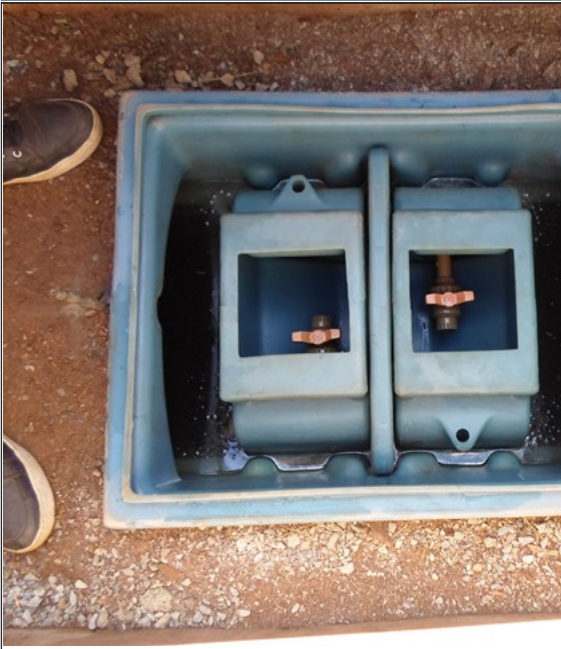
Foto 20 – Caixa Separadora do SAO da pista de
