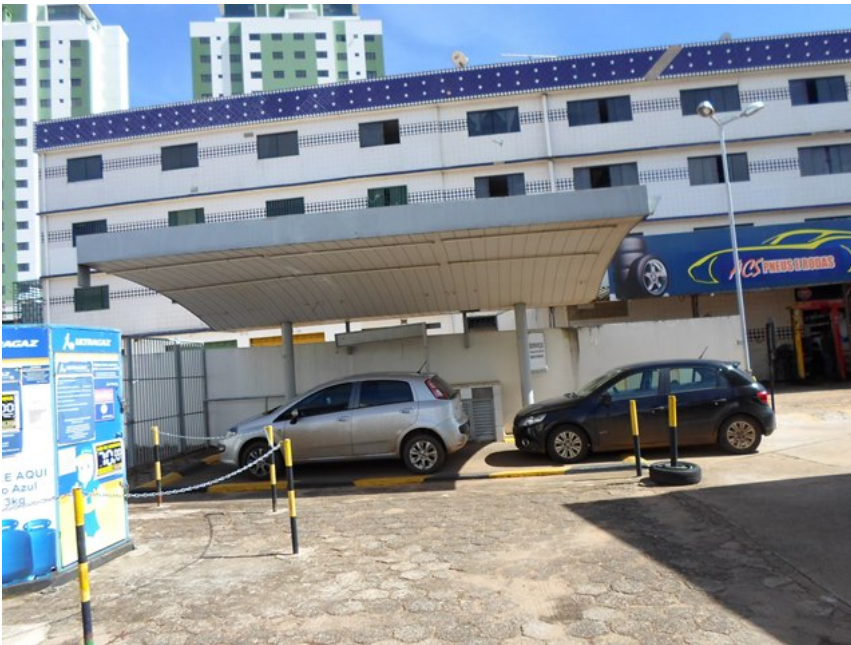
Foto 34 – Visão Geral da Área de Lavagem.
