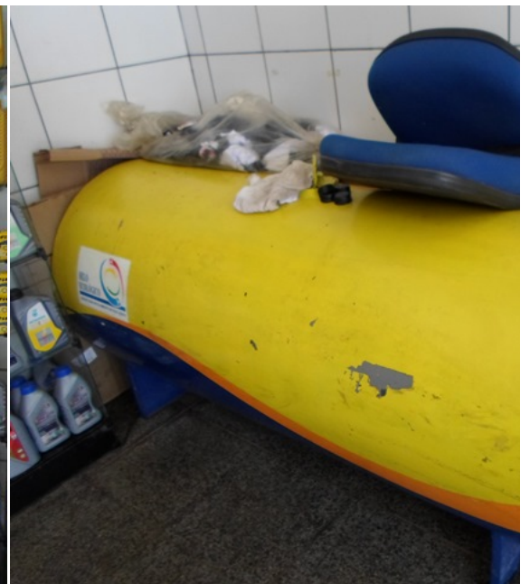
Foto 33 – Tanque aéreo de OLUC em local coberto e circundado por lixo.
