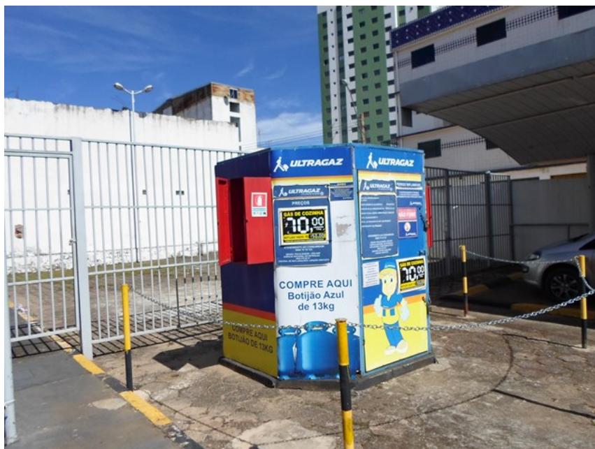
Foto 37 – Armazenamento de GLP para revenda.
