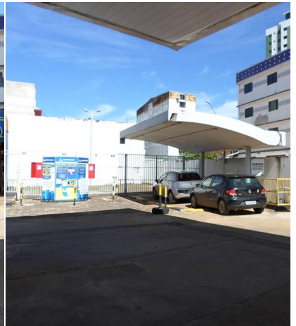
Foto 35 – Área de Lavagem, que encontra-se
