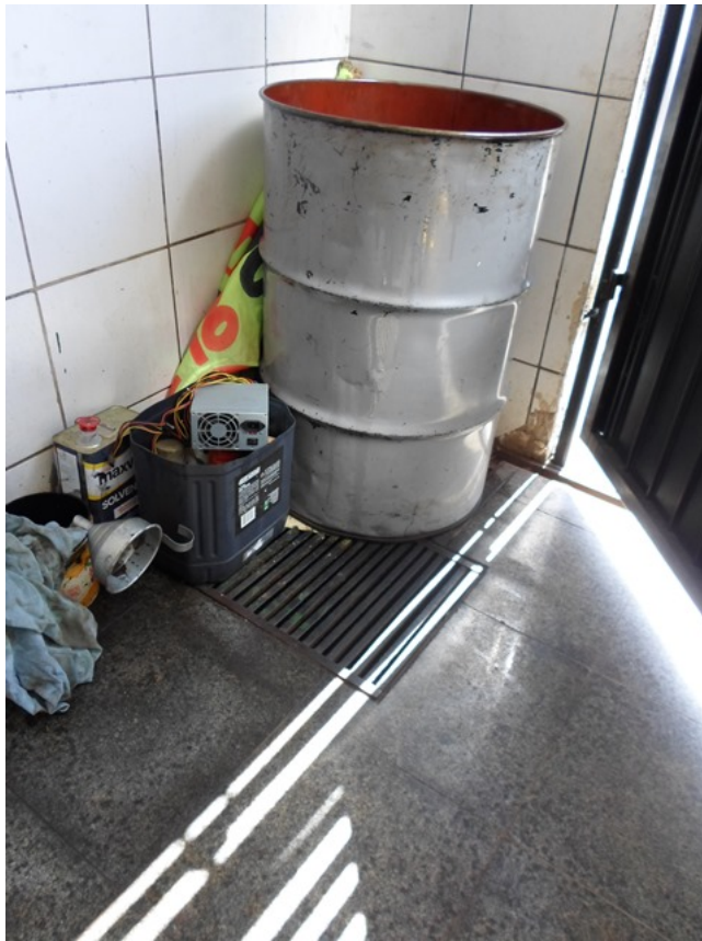
Foto 30 – Detalhe do tambor de resíduos classe 1, aberto e sem tampa e da grelha.
