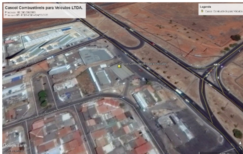
Foto 1 - Localização do Empreendimento. Imagem retirada do Software Google Earth - Pro – Data da imagem: 31/08/2017
