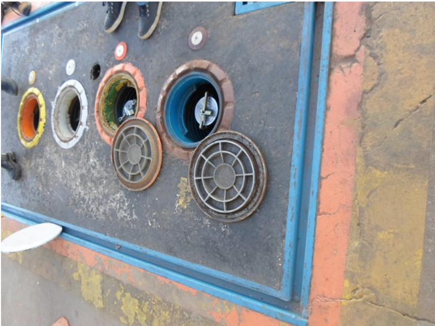
Foto 14 – Descarga Selada à distância circundada por Canaletes.
