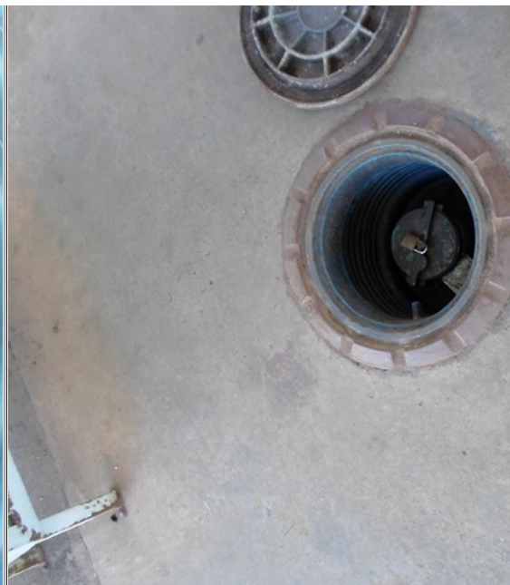
Foto 27 – Detalhe da Descarga Selada sobre o piso de concreto.
