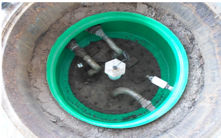
Foto 2: Visão geral da bacia de contenção.
