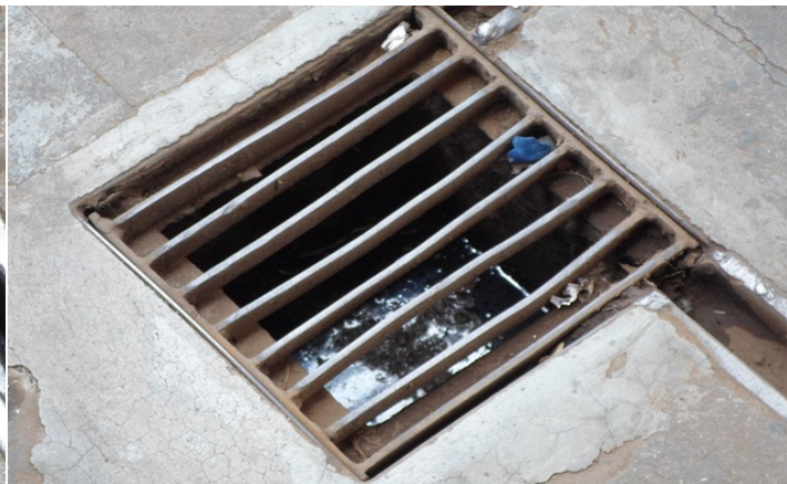
Fotos 6 e 7: Foto detalhada dos canaletos sem manutenção adequada.
