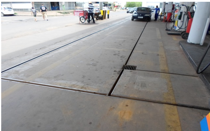
Fotos 4 e 5: Visão geral dos canaletos na pista de abastecimento.
