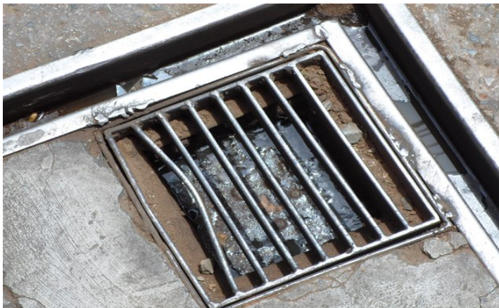
Fotos 6 e 7: Foto detalhada dos canaletos sem manutenção adequada.
