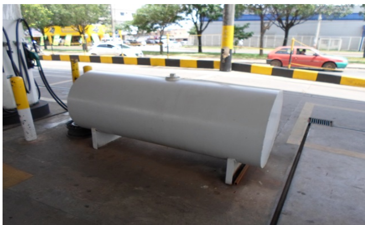
Foto 15: Local de armazenamento do OLUC.
