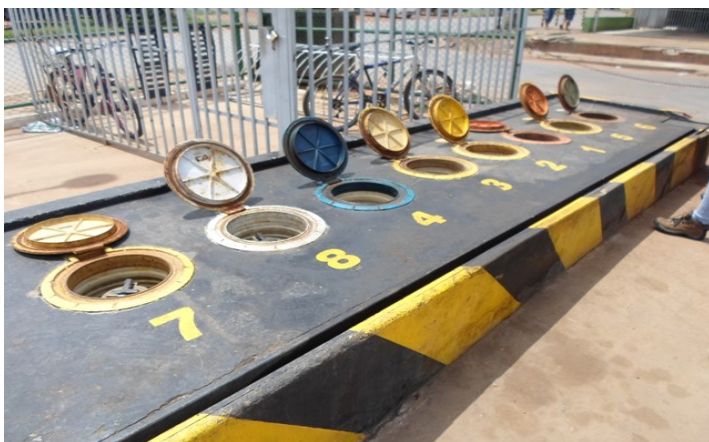
Foto 8: Descargas seladas à distância.
