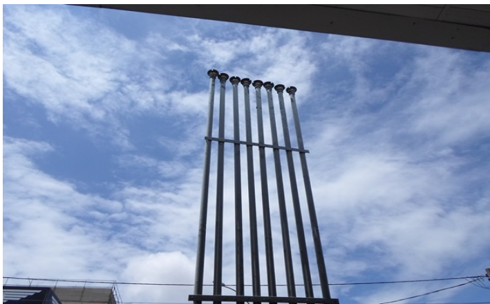
Foto 10: Respirios dos tanques.
