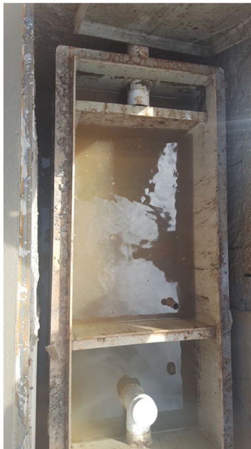
Foto 09 - S.A.O da área de lavagem, que no momento da vistoria estava sendo instalado
