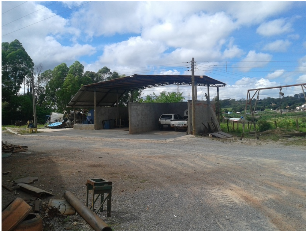
Foto 7- Galpão para manutenção de máquinas e equipamentos. Área de abastecimento com piso impermeável e circundada por canaletas. Tanque aéreo em local coberto e com bacia de contenção.
