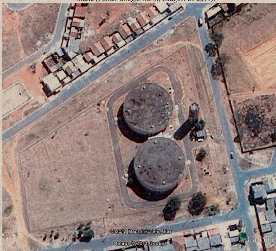
Figura 02 – Lote da CAESB onde funciona o Centro de Reservação Santa Maria, verifica-se também a disponibilidade de área para a implantação da Estação Elevatória de Água Tratada – EAT Santa Maria (Fonte: Google Earth, imagem de 2011).
