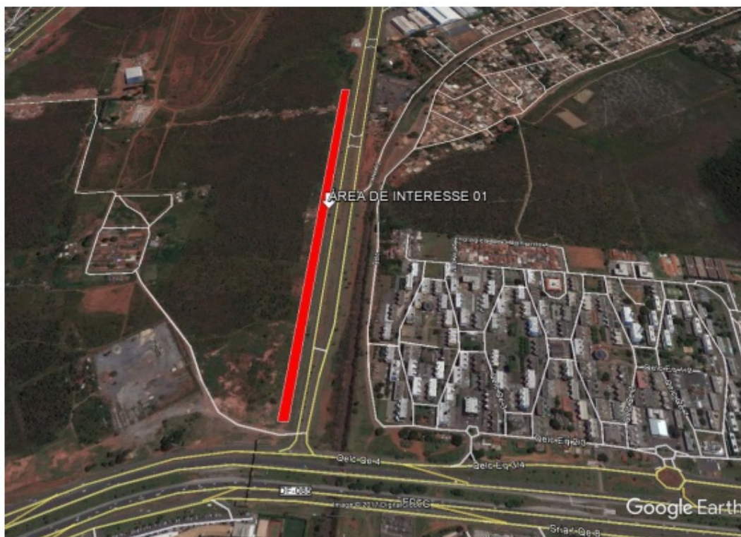
Figura 1: Área de Supressão da Caixa de Empréstimo às margens da via de ligação EPTG/STRC
