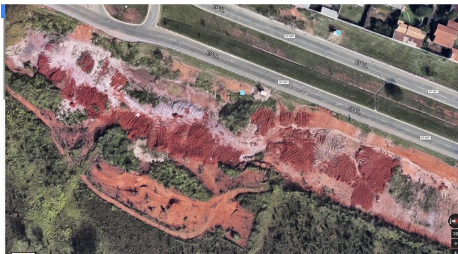
Figura 7 - Resíduos sólidos depositados irregularmente sobre as bacias na faixa de de domínio da DF-087
