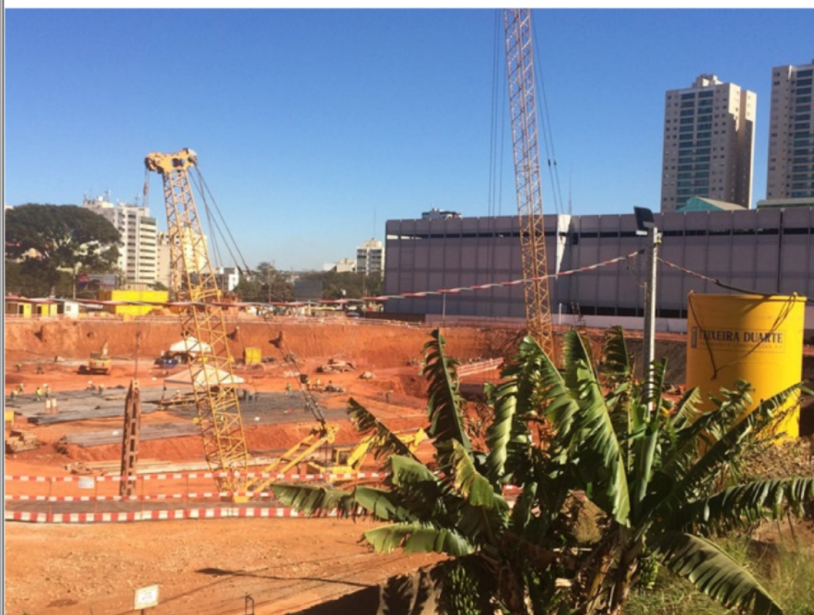
Obra de Terraplanagem
