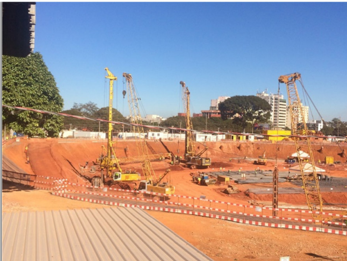
Obra de Terraplanagem
