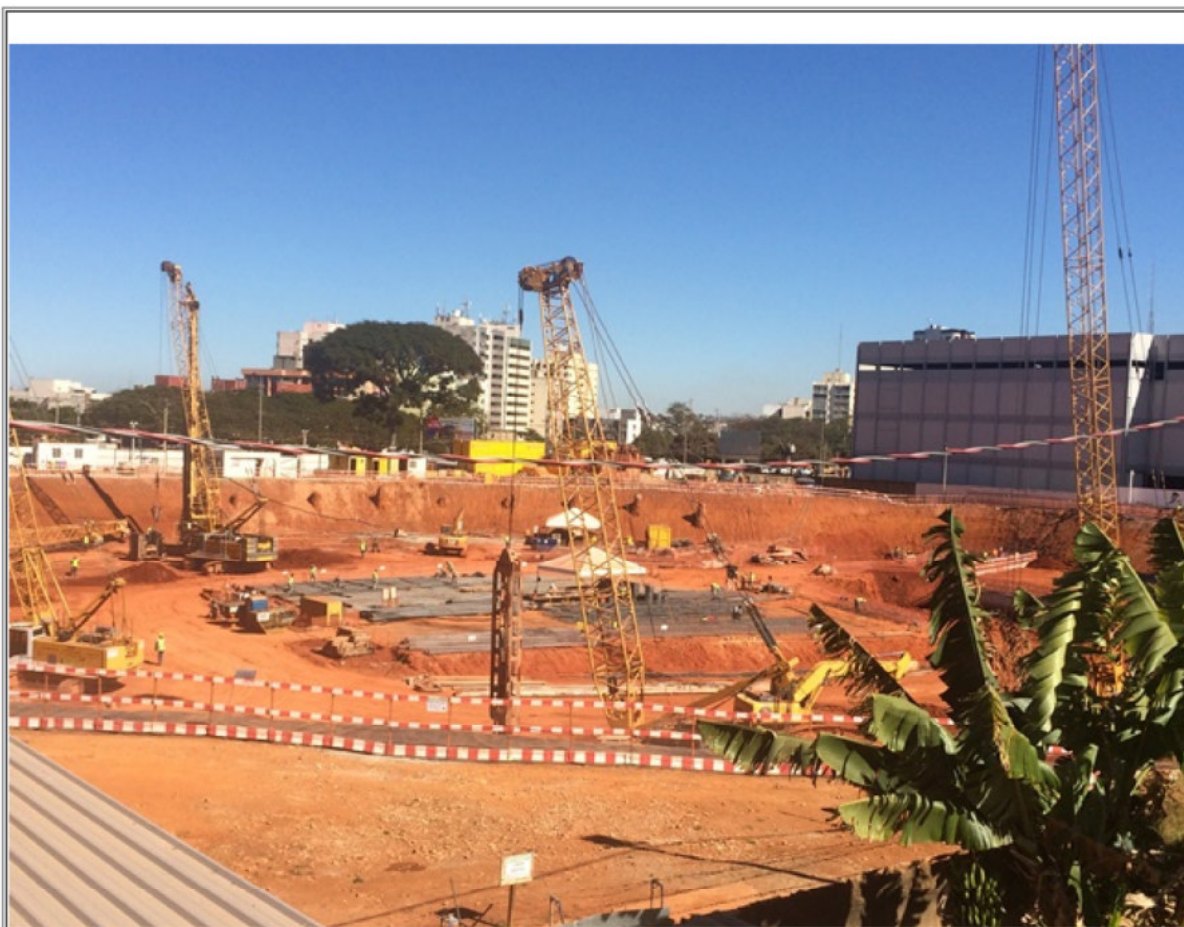
Obra de Terraplanagem
