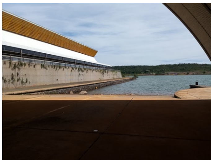
Foto 4: Local coberto para armazenamento dos materiais.
