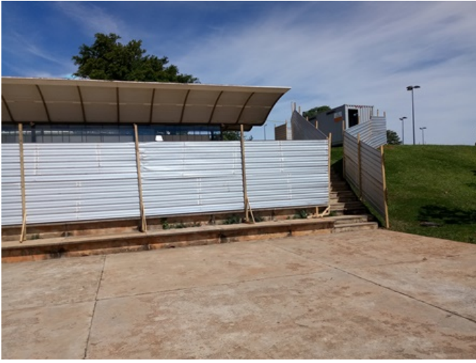
Foto 5: Container de vestiários e banheiros.
