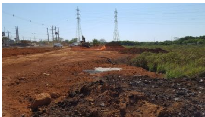
Foto 15: Área em atividade construtiva.
