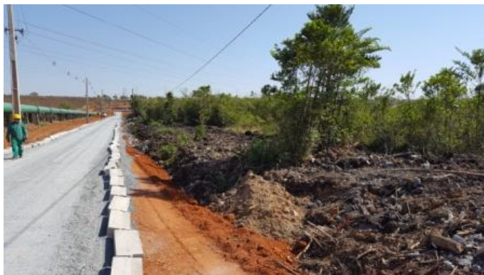
Fotos 13: Abertura de caminho de acesso.
