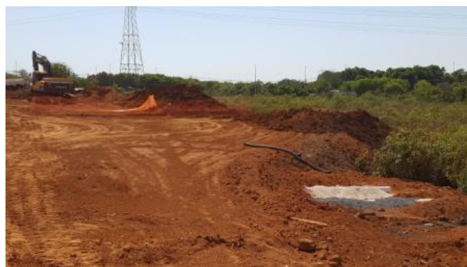
Foto 16: Área em atividade construtiva.
