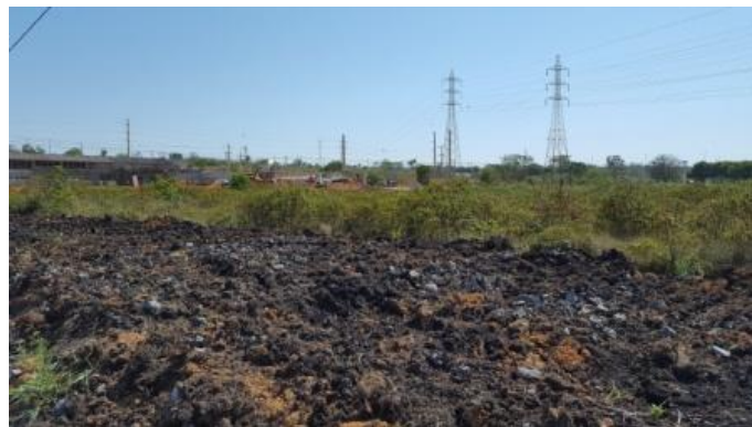
Fotos 14: Abertura de caminho de acesso.
