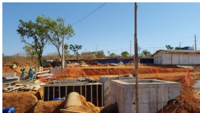
Foto 02: Canteiro de Obras.
