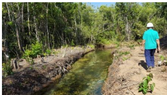
Foto 06: Canal de desvio do Córrego Bananal - montante.
