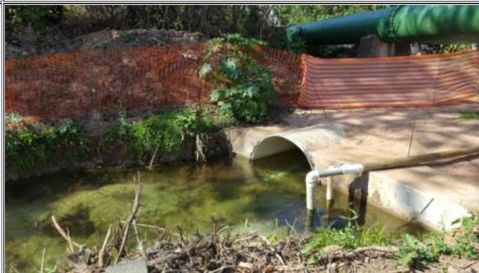
Foto 08: Canal de desvio do Córrego Bananal - jusante.
