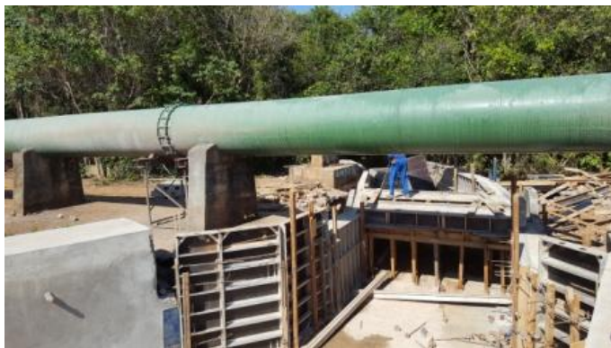
Foto 11: Canal de captação.
