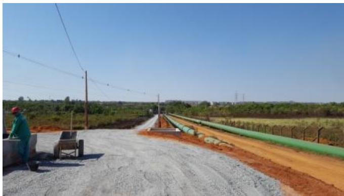
Foto 03: Área de instalação da adutora.
