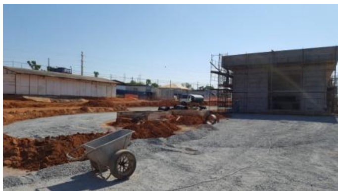
Foto 01: Canteiro de Obras.
