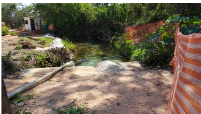
Foto 09: Canal de desvio do Córrego Bananal - jusante.
