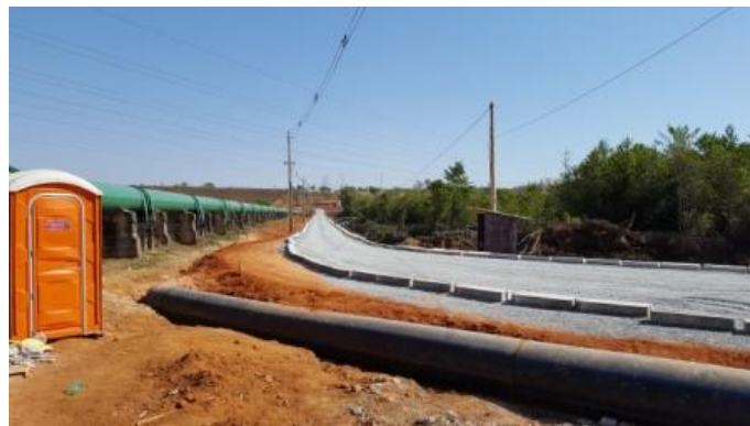
Foto 04: Área de instalação da adutora.
