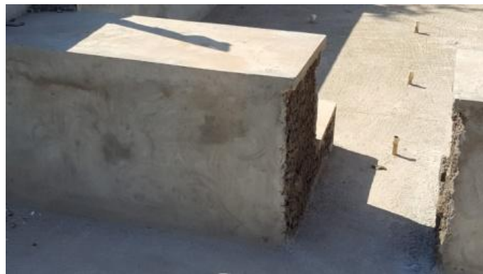
Foto 12: Canal de captação (detalhe do gabião em caixa com revestimento).
