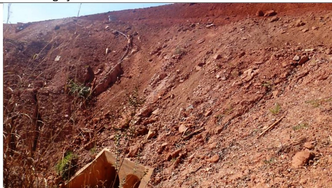
Figura 3 – Verifica-se bueiro na base da saia do talude
