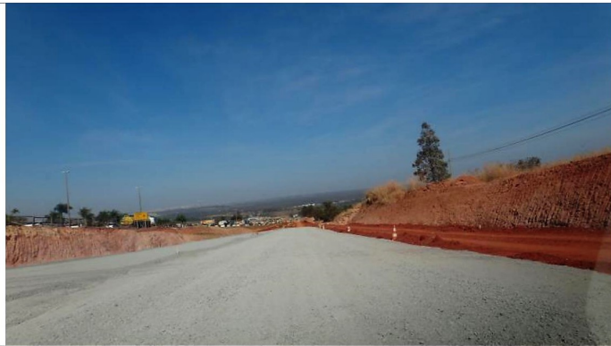
Figura 1 – Trecho em corte das obras de ampliação da via de interligação Torto- Colorado.
