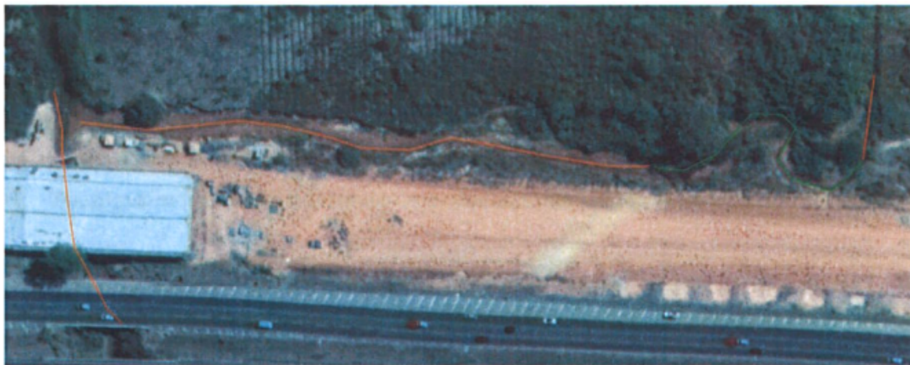
Figura 13: Discriminação dos trechos com escavação manual (linha verde) e mecânica (linha laranja).
