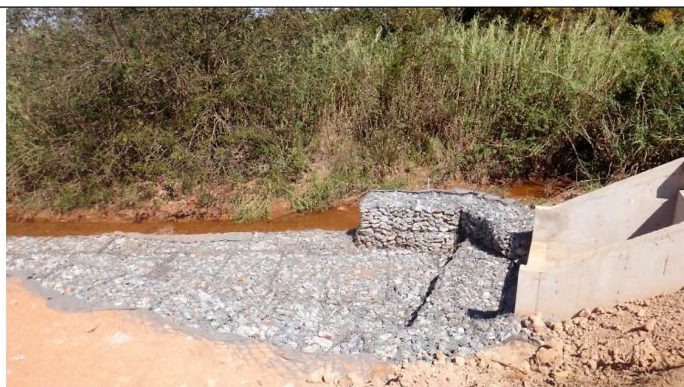
Figura 7 – Lançamento final no córrego Açude com dissipador de energia.
