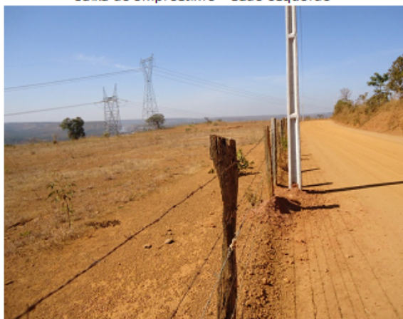
Presença de rede de energia elétrica
