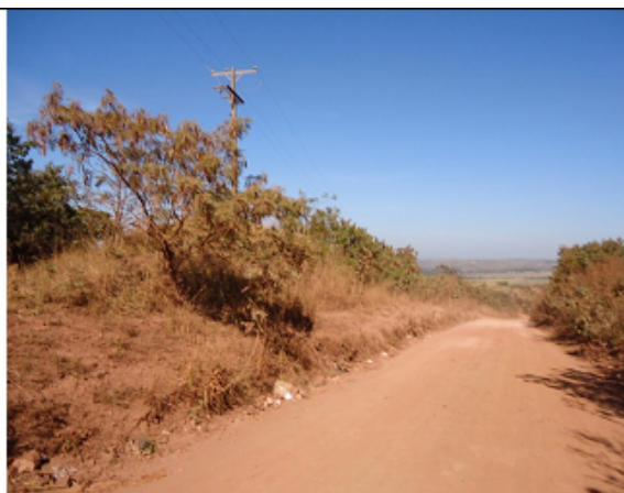
Caixa de empréstimo – detalhe da rede de energia
