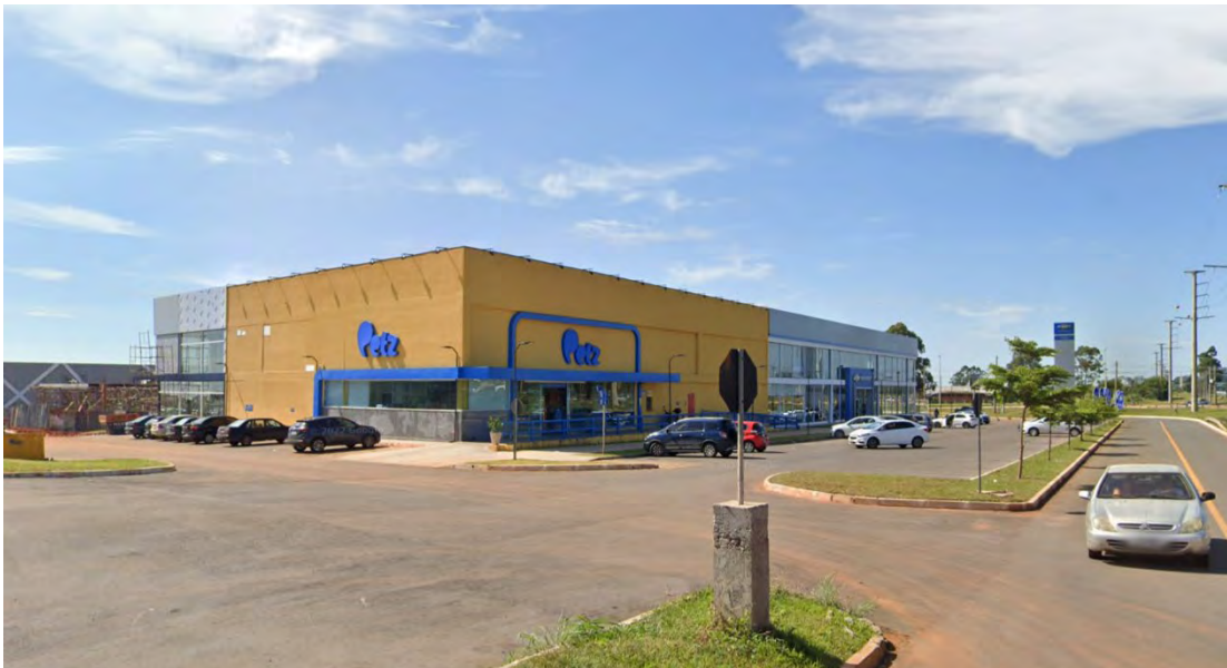
Figura 76 - Área comercial junto a DF-463, próximo ao parcelamento Jardins Mangueiral
