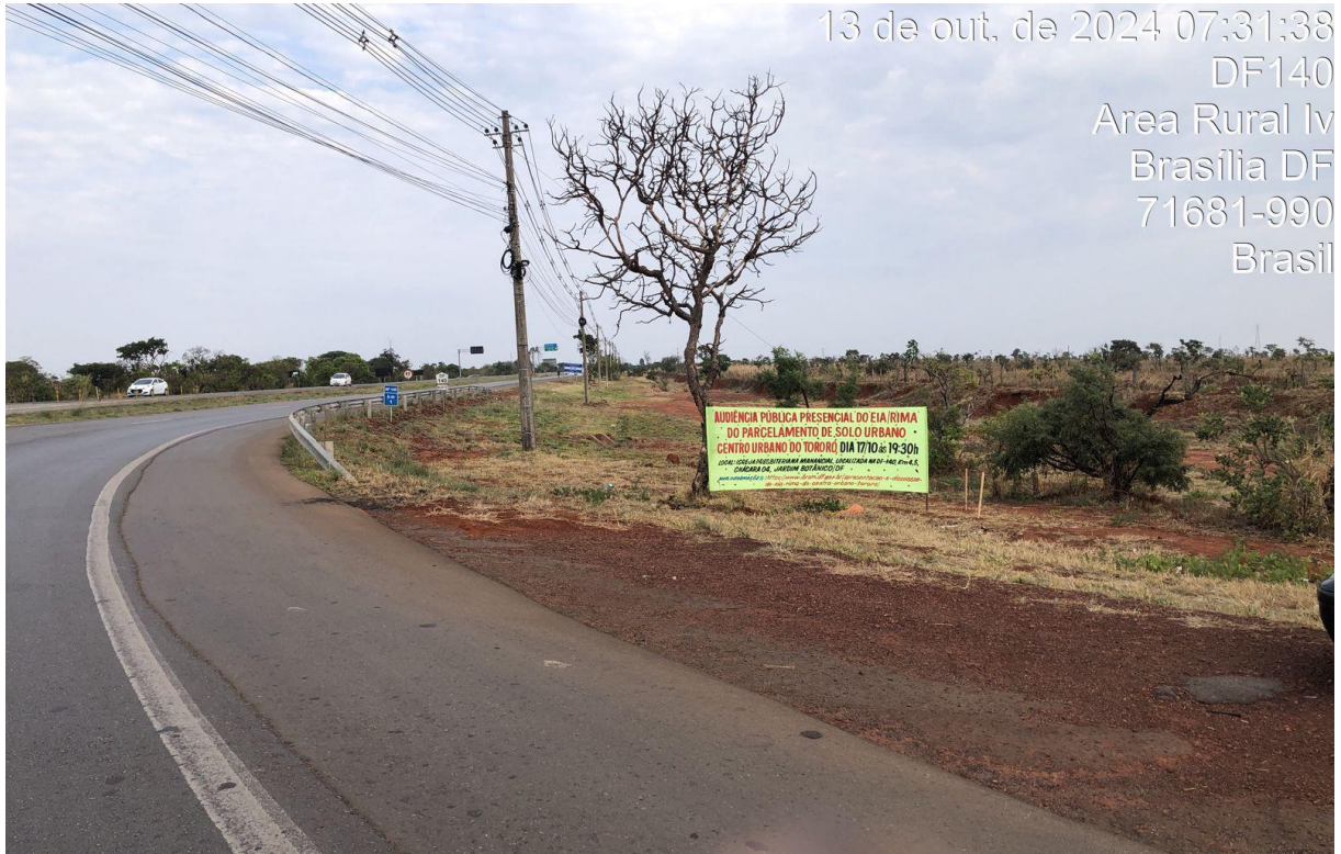
Figura 3: Faixa de divulgação da audiência pública para a comunidade local na área do empreendimento, às margens da DF-140
