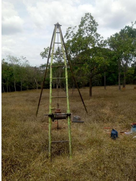
Sondagem à percussão SPT – 11/01/2024
