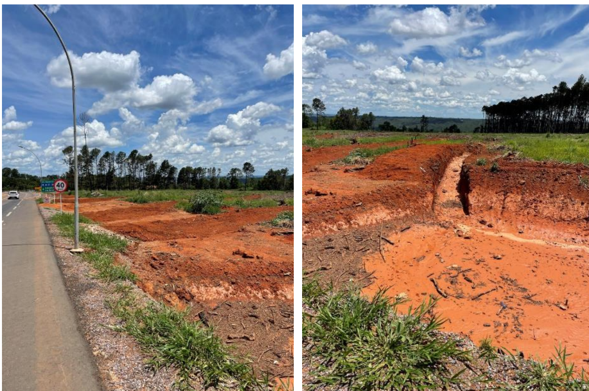
Figura 196: Exemplo de Leiras, bacias de contenção e bigodes – estruturas provisórias para redução de energia do escoamento superficial das águas pluviais (Fotografia Christian Della Giustina, 2023).
