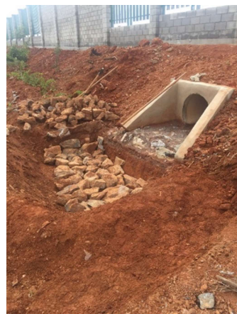
Figura 111. Caixas provisórias para redução de energia de águas pluviais e retenção de sedimentos. Fotografia: Paranoá Consultoria.
