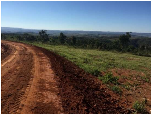
Figura 108. Leiras para redução de energia e de sedimentos decorrentes do escoamento superficial. Fotografia: Paranoá Consultoria.
