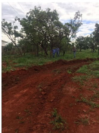
Figura 110. “Bigodes” para dissipação de energia de picos de precipitação e escoamento superficial. Fotografia: Paranoá Consultoria.
