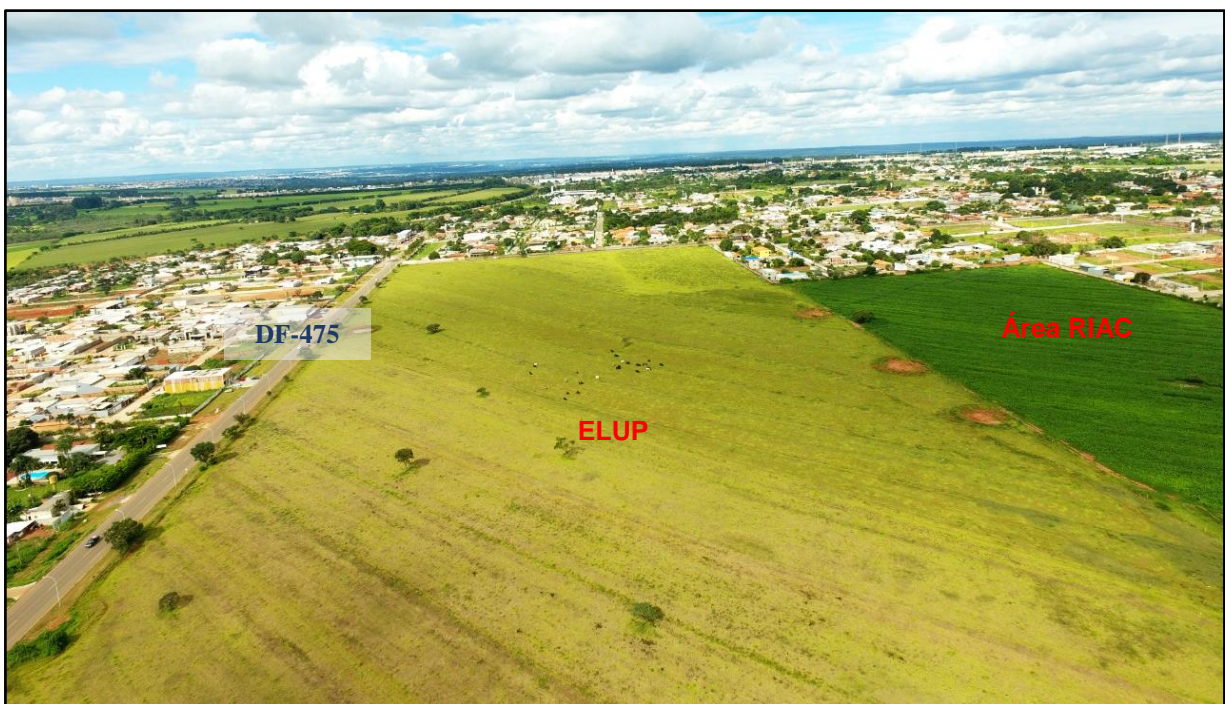
Foto 8. Vista de grande área destinada a equipamento institucional ELUP.
