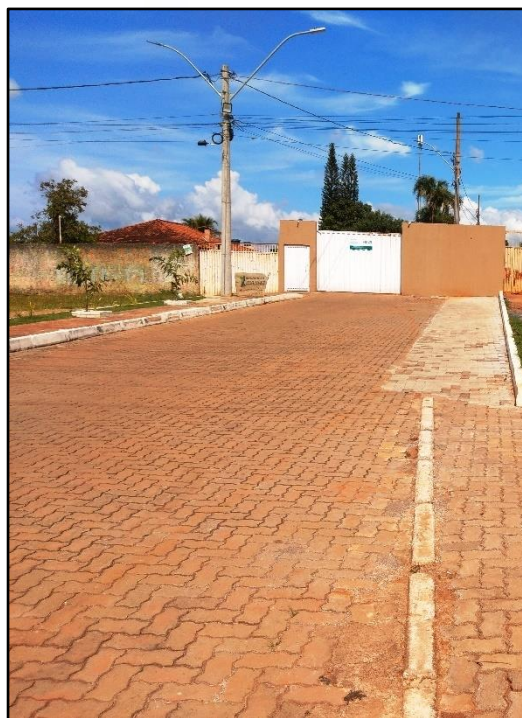
Fotografia 27. Via interna de acesso ao condomínio em bloquete.
