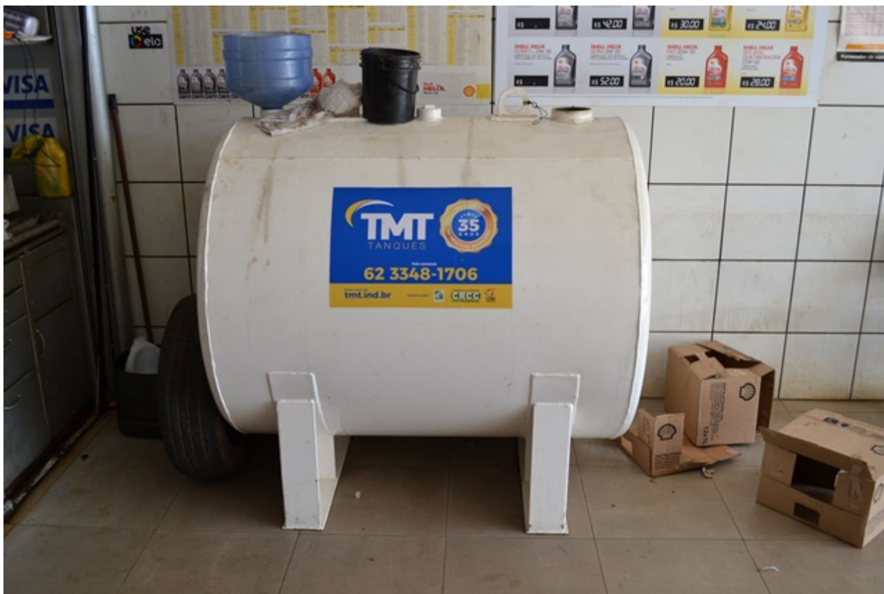
Figura 20: Tanque aéreo de OLUC, presente em local coberto e cercado por canaletes direcionados ao S.A.O.
