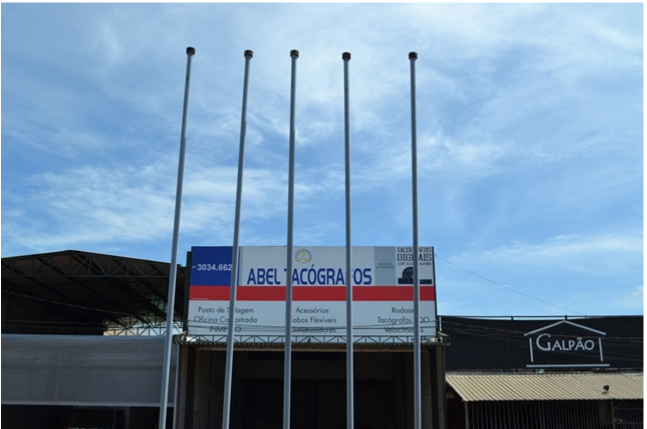
Figura 5: Cinco respiros com terminal corta-chamas.
