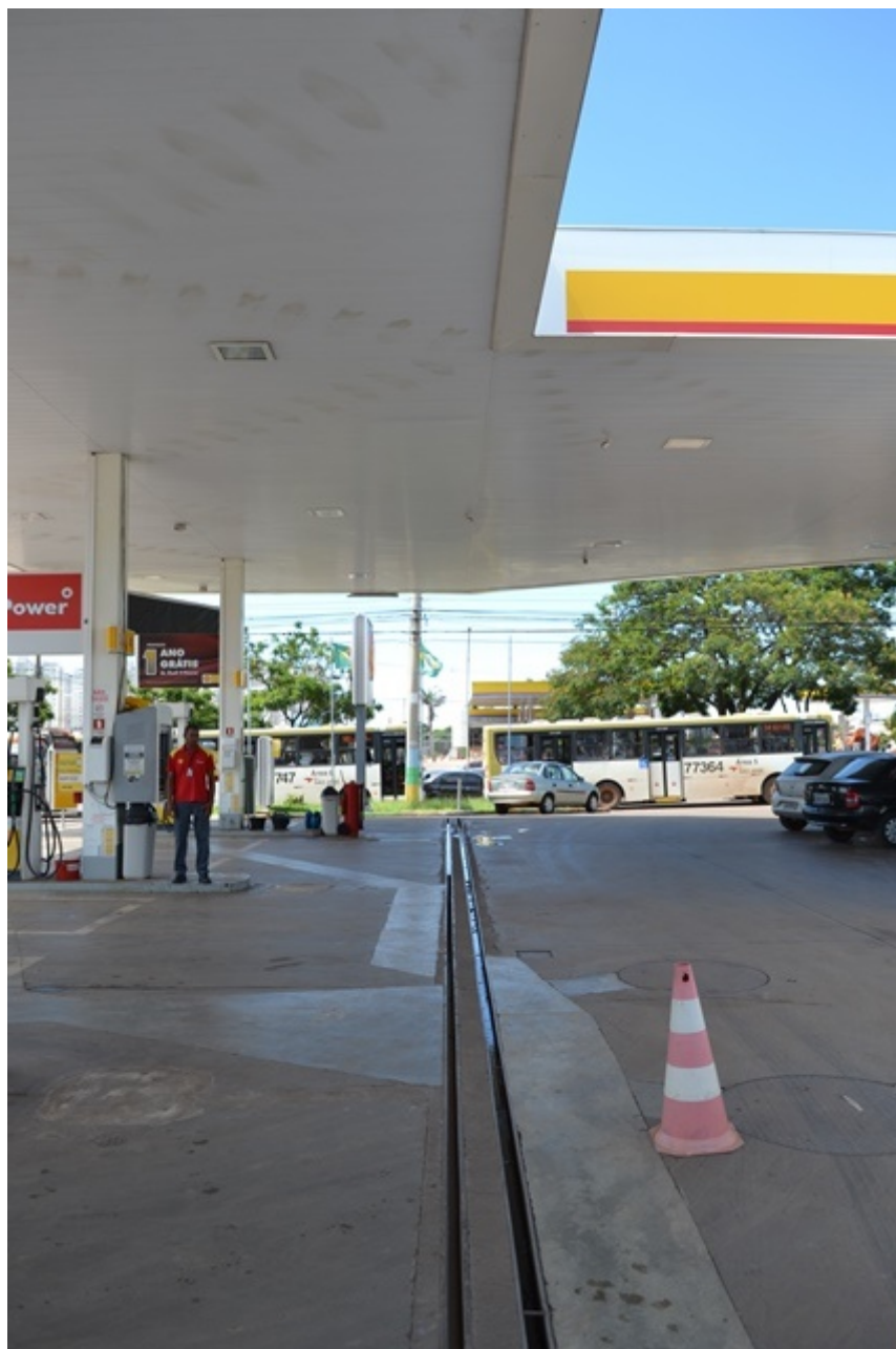
Figura 10: Conjunto de canaletas da área da pista de abastecimento. O canaleta (esquerdo) corresponde ao SDO e o (direito) da drenagem de águas pluviais.
