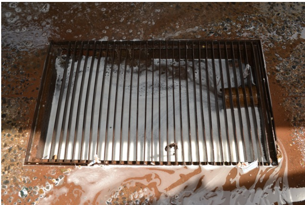
Figura 16: Caixa central com grade da área de lavagem de veículos, direcionadas ao S.A.O. exclusivo.
