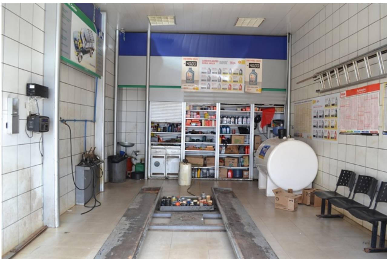
Figura 19: Área de lubrificação de veículos, com 1 elevador, tambores de resíduos classe 1 e tanque de OLUC aéreo.
