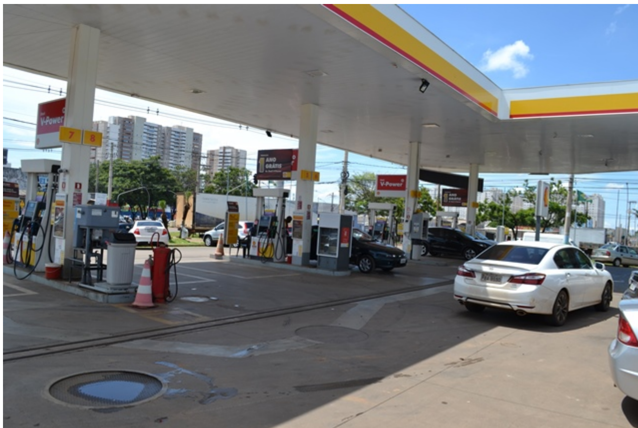
Figura 9: Pista de abastecimento com quatro ilhas, com uma unidade abastecedora cada e apresentando 6 bicos injetores de combustível em cada unidade.
