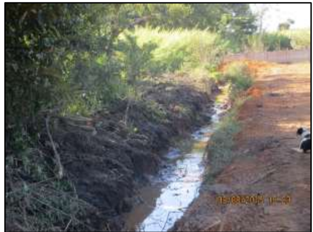
Foto 26: Vala escavada para captação de água no leito do córrego Paranoazinho.
