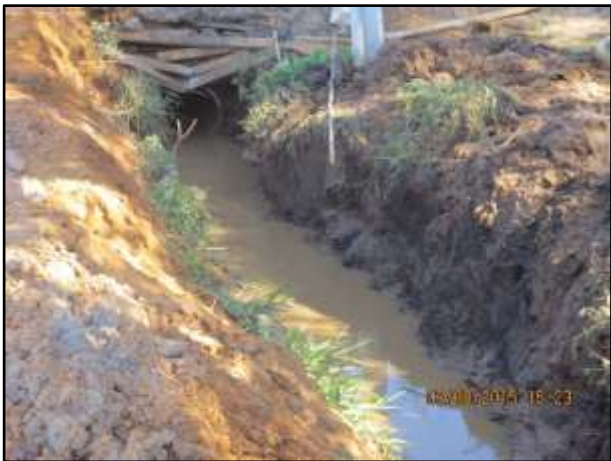
Foto 25: Vala escavada para captação de água no leito do córrego Paranoazinho.
