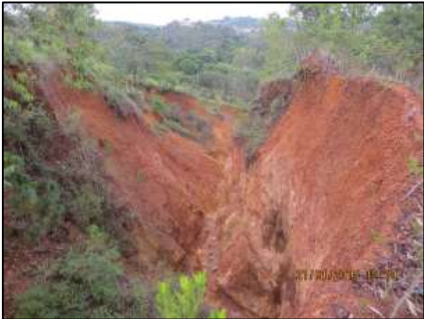
Foto 9: Feição do sulco erosivo existente na divisa da gleba onde se projetou o Sítio Vila Célia e o lote vizinho.
