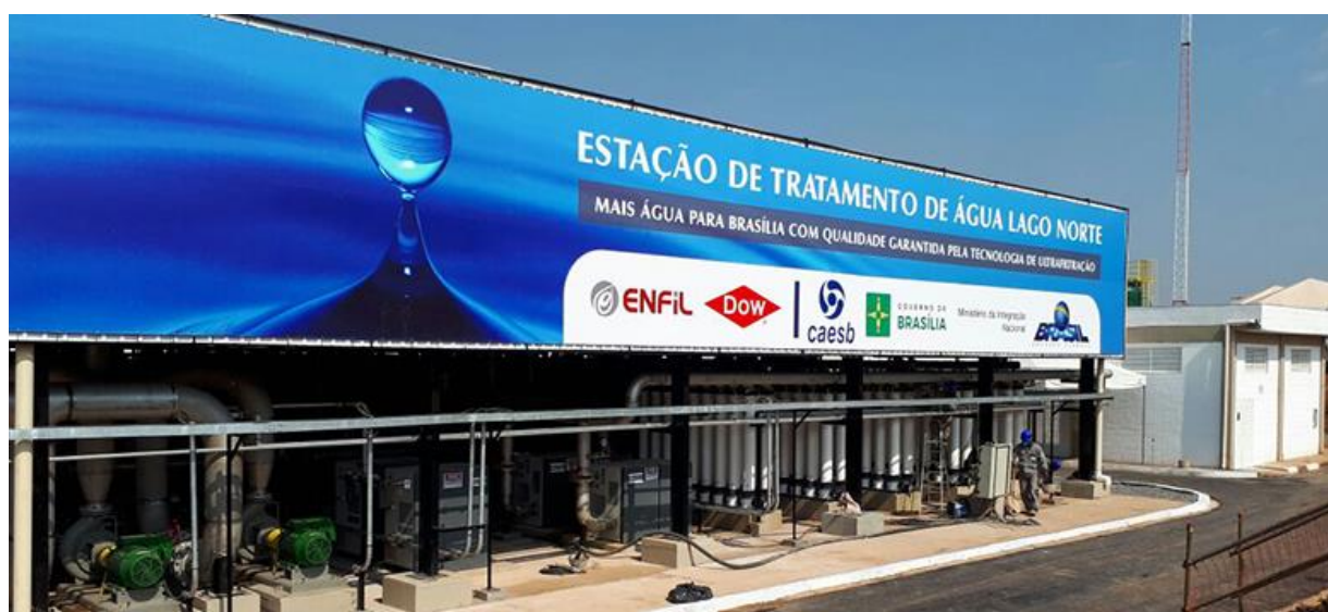
Figura 11 - ETA Lago Norte – Tecnologia de membranas 700 L/s
