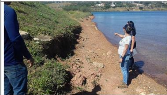
Figura 6 – Local aproximado de um trecho proposto para a via de acesso ao canteiro, que segue na base do aterro da ponte. Verifica-se ausência de vegetação e desprendimento de sedimentos do talude.
