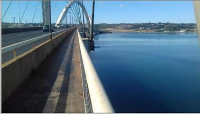
Figura 4 – Visualizam-se as estruturas de fixação dos estais
