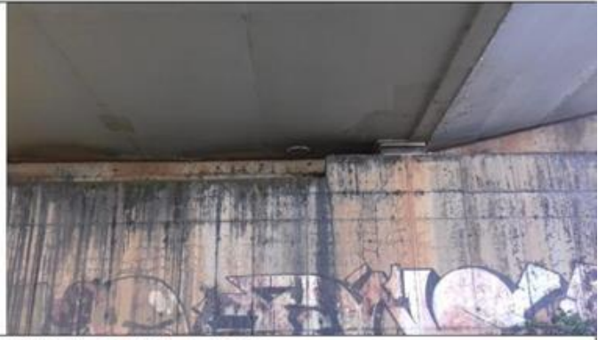
Figuras 2 e 3 – Fissuras na estrutura de concreto da ponte.
