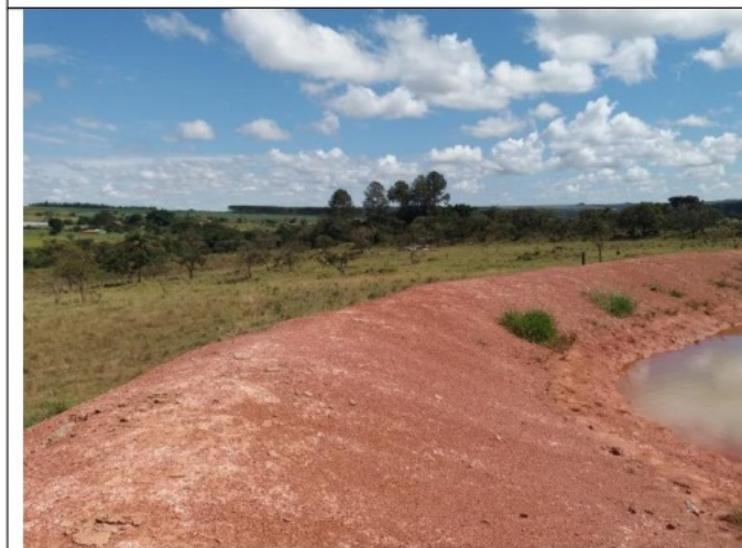
Foto 15 – Vista do talude da bacia de retenção.
