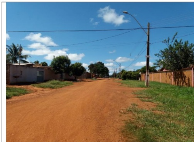
Foto 1 - Rua interna a ser pavimentada no Núcleo Rural Taquara.
