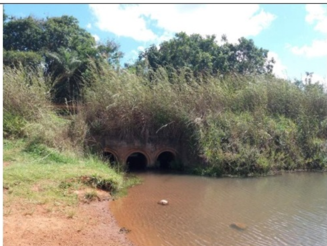
Foto 20 – DF-230 sobre o córrego Taquara.
