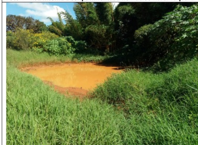
Foto 3 - Bacia de detenção às margens da Via 01.
