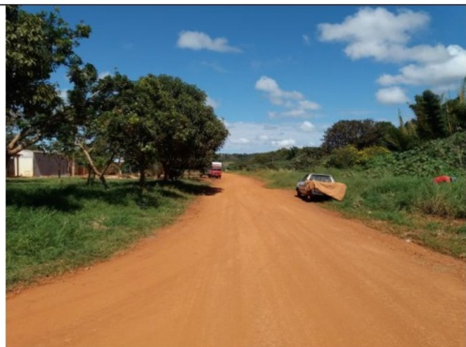
Foto 2 - Vista da Via 01 a ser pavimentada.
