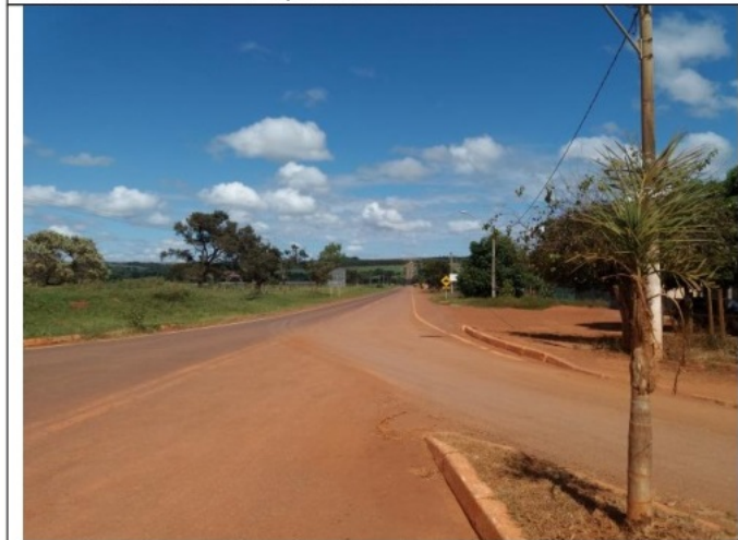
Foto 11 – Vista da DF-230.
