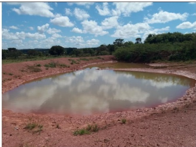
Foto 14 – Bacia de retenção no final da Via 01, direcionando a água excedente para o córrego Taquara.
