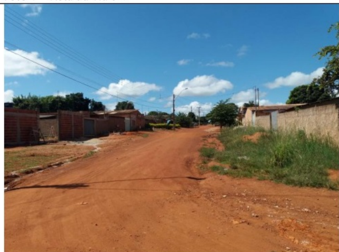
Foto 6 - Vista de uma das ruas internas a ser pavimentada.
