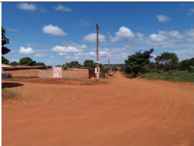
Foto 8 – Vista geral da Via 01.
