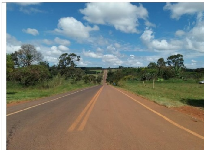
Foto 19 – DF-230, sentido oeste.
