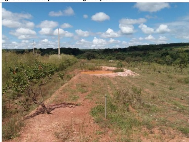
Foto 16 – Bacia de retenção próxima ao córrego Taquara.
